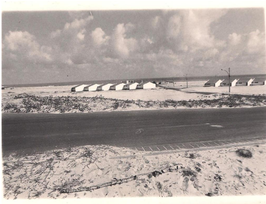
Imagem IX: 1ª etapa de construção da Colônia de Férias dos Professores – Praia do Pecém (1979) 571
