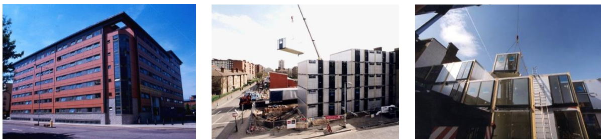
Figura 17 – Royal Northern College of Music , em Manchester, composto por 900 módulos e núcleos de aço apoiados, e instalação de unidades modulares em Murray Grove , Hackney, Londres
