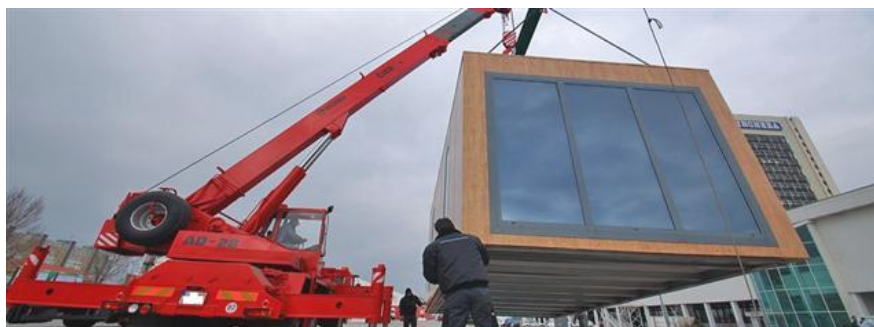
Figura 31 – Exemplo instalação de módulo pronto com os fechamentos
