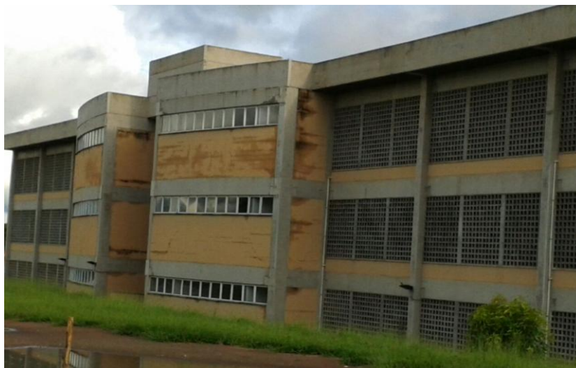
Figura 53 – Edifício AT7: Fachada Norte
