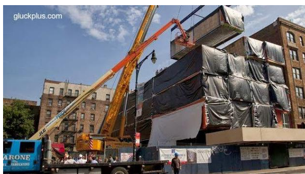
Figura 20 – Gruas empilhando os módulos na base do terreno
