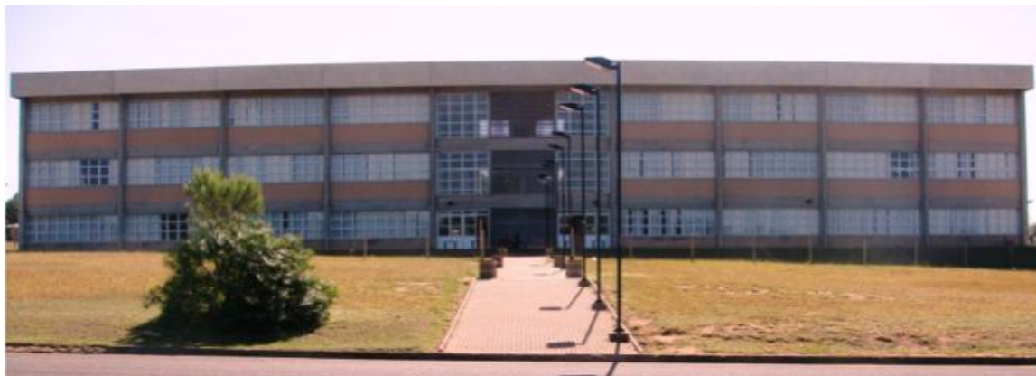
Figura 52 – Edifício AT7: Fachada Sul
