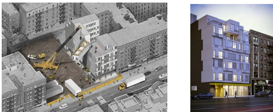
Figura 19 – Montagem dos módulos e edifício pronto
