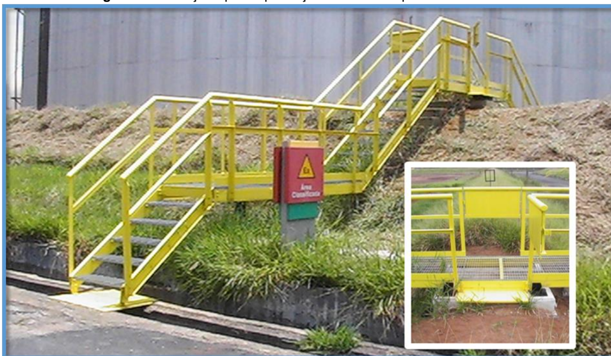
Figura 22 Validação após implantação definitiva de plataforma metálica
