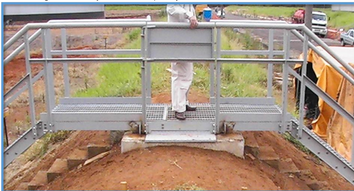
Figura 21 Validação durante a implantação dos acessos com escadas metálicas
