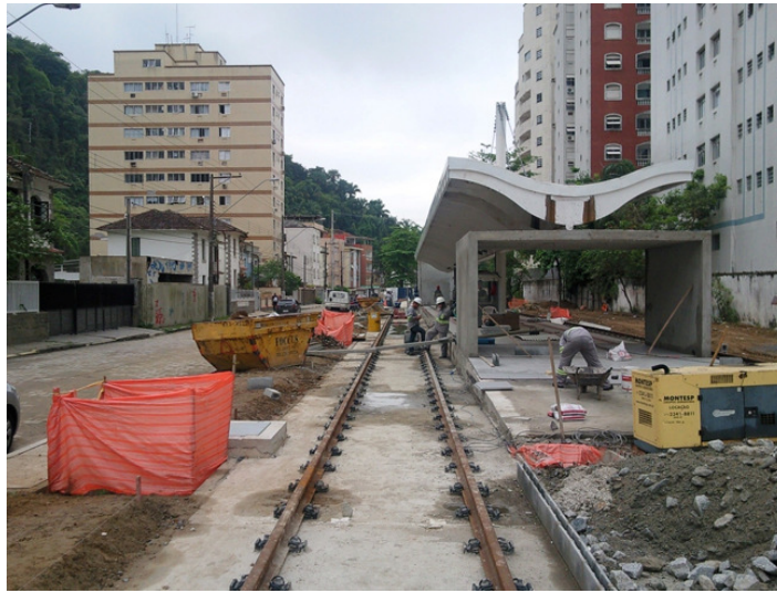
Figura 75 - Estação Itararé em São Vicente ainda em obras Fonte: EMTU (2014)
