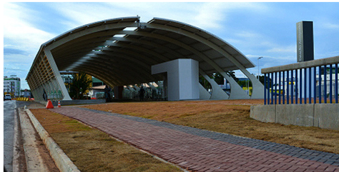
Figura 93 - Terminal do VLT no Aeroporto em Várzea Grande – MT Fonte: Cuiabá 3001 (2015)
