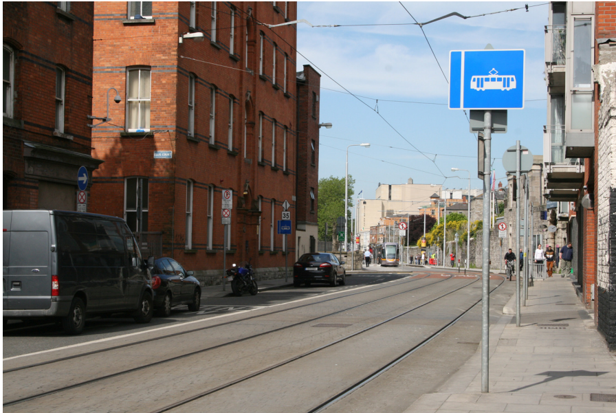
Figura 35 - Via compartilhada pelo VLT, veículos rodoviários e ciclistas em Dublin. Fonte: Transport for Ireland (2014)
