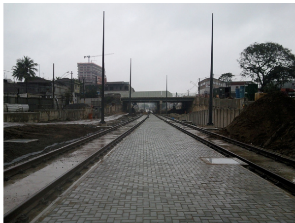
Figura 82 - Viaduto Antonio Emmerich adaptado ao VLT Fonte: EMTU (2014)
