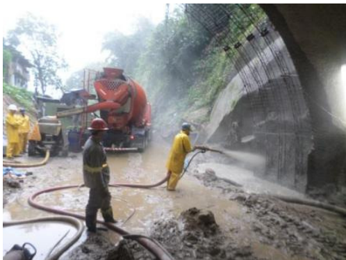
Figura 79 - Túnel José Menino em obras de alargamento Fonte: Ebah (2014)
