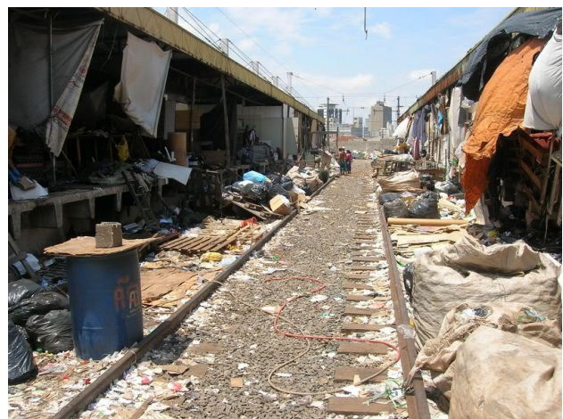
Figura 2 - Estação Barão de Itapura em Campinas abandonada Fonte: Skyscrapercity (2008a)
