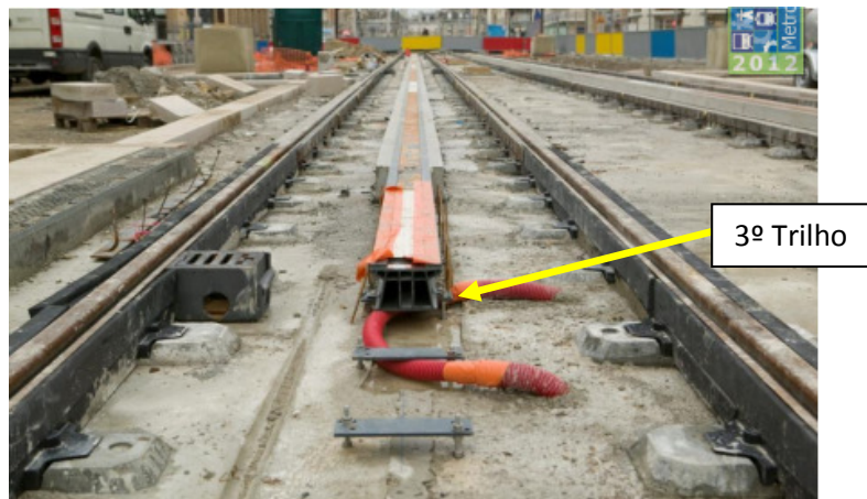
Figura 99 - Implantação do Sistema APS - 3º trilho Fonte: Farcette (2012)
