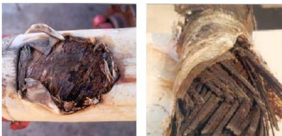
Figura 1.3 Efeito da corrosão nas armaduras de tração de uma linha flexível devido a fissuras na camada polimérica externa [7].
