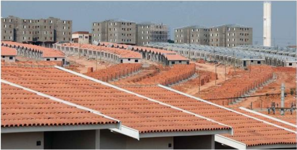
Figura 5 - Unidades Habitacionais do PMCMV no Residencial Casa do Parque em Campinas (SP)
