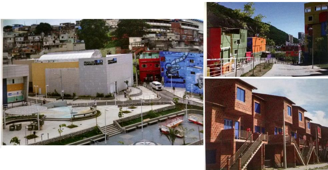
Figura 3 - À esquerda, urbanização da Favela da Rocinha com qualificação do espaço público, à direita (acima), urbanização do Complexo do Alemão (ambas no RJ) e, à direita (abaixo), conjunto Vila do Mar, em Fortaleza, destinado a abrigar famílias removidas de favela
