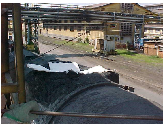
Figura 6.26 Colocação da Tampa sobre a Boca do Carro Torpedo.
