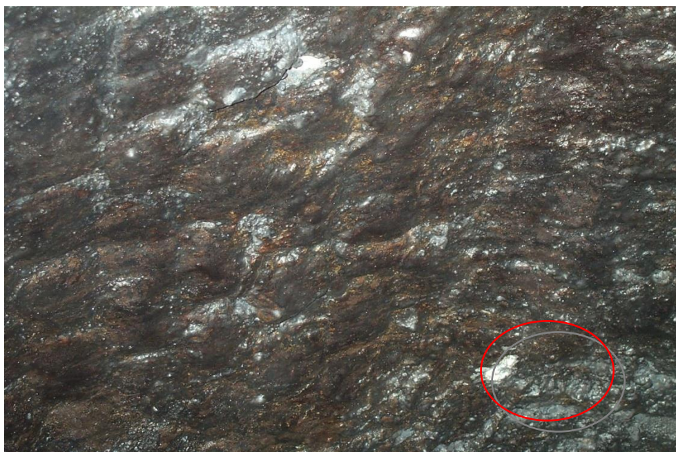
Figura 6.29 Foto do Revestimento Refratário do CT#12 – Cilindro Após Testes Industriais de Slag Coating.
