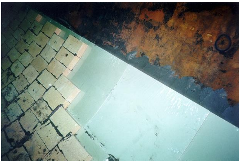
Figura 6.5 Detalhe da Instalação das Placas de Sílica Microporosa.
