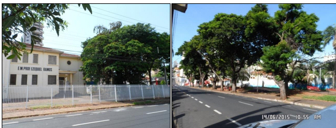
Figura 3. Fachadas (principal e lateral) da escola
