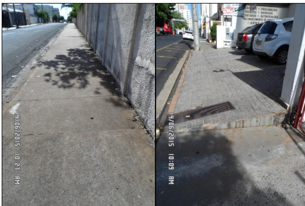
Figura 9. Acessibilidade: trechos sem desníveis e trechos intransitável para cadeirante.
