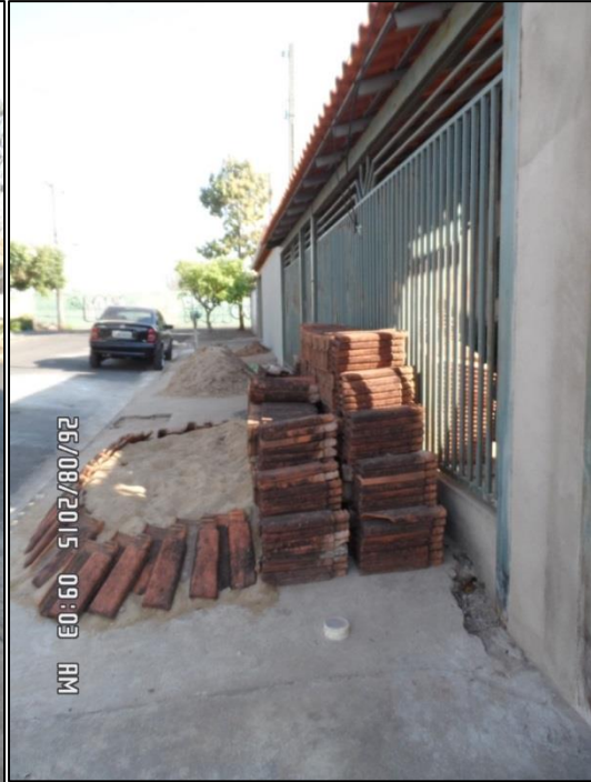
Figura 11. Infraestrutura para pedestre.
