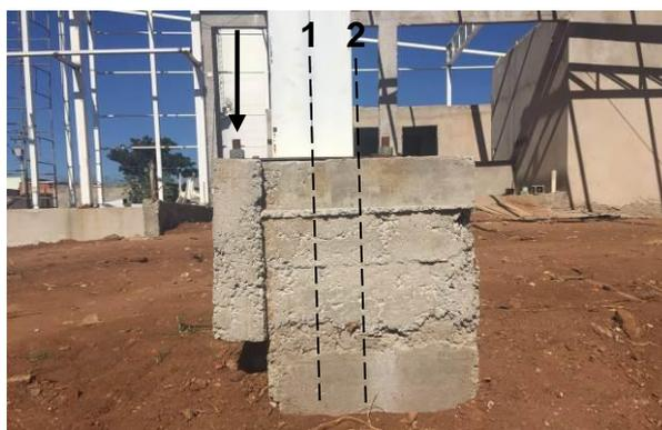
1 – Eixo do pilar; 2 – Eixo do Bloco de fundação.
