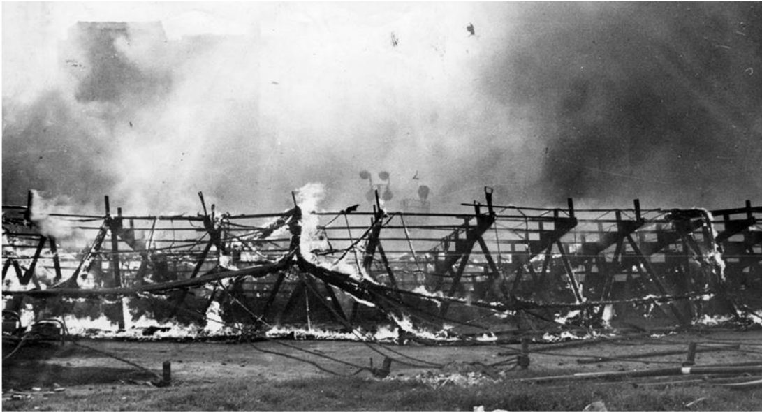
Figura 4 - Registro fotográfico do incêndio
