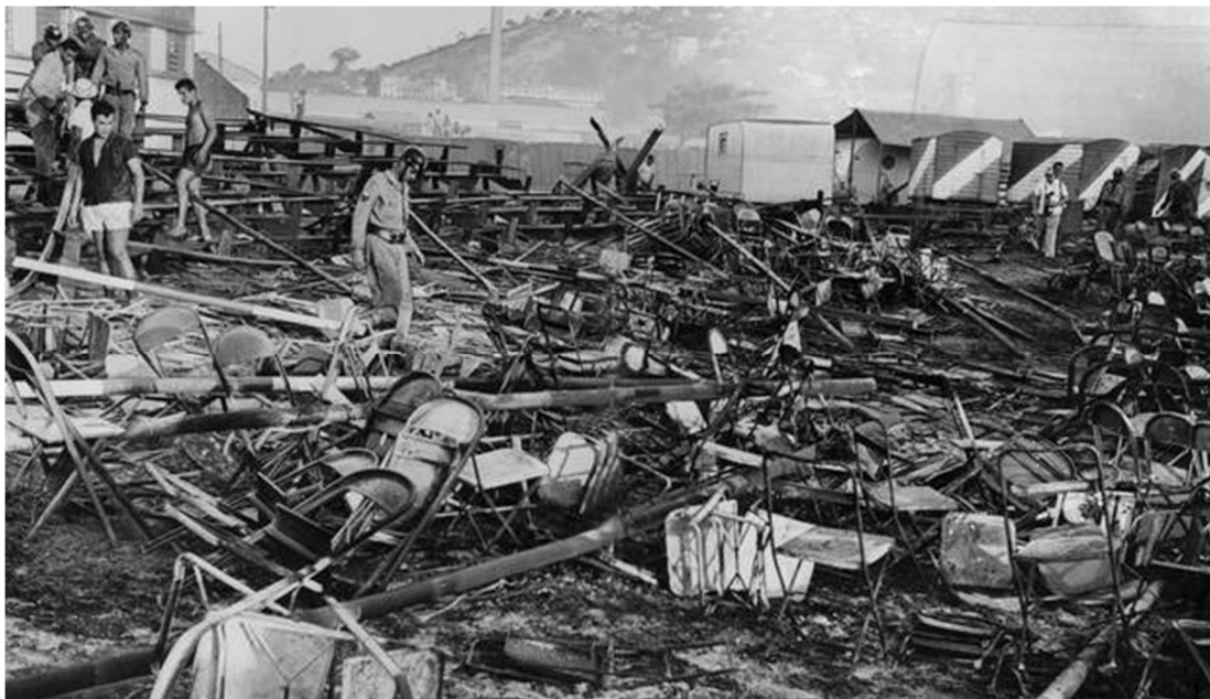
Figura 5 - Bombeiros trabalham nos restos do incêndio
