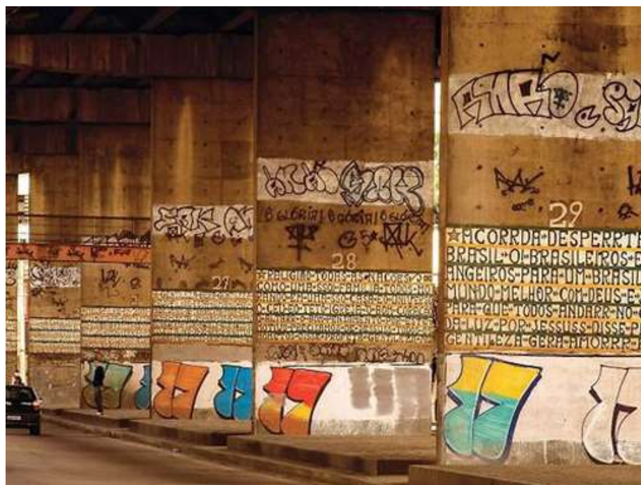
Figura 25 - A obra depois de restaurada
