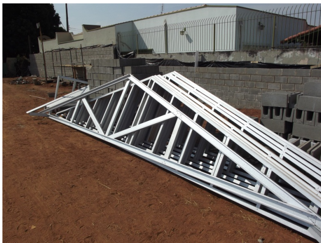
Figura 21: Exemplo de tesouras em LSF
