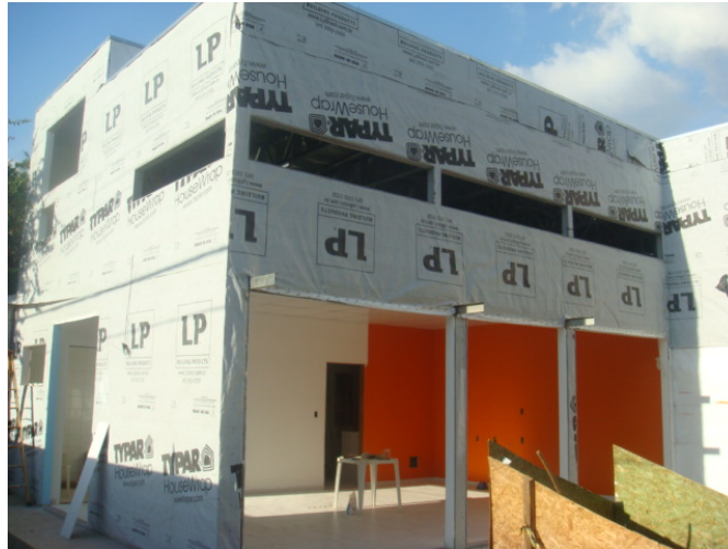
Figura 14: Edificação em LSF vedada com OSB e revestida com manta de polietileno
