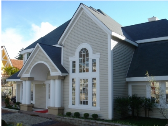
Figura 16: Exemplo de aplicação do siding vinílico em fachada residencial
