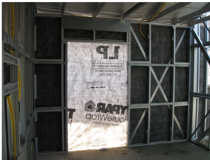
Figura 27: Abertura para esquadria em painel em LSF
