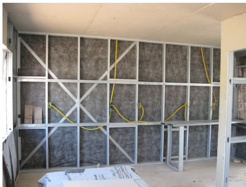
Figura 10: Painel contraventado com fita metálica e instalações prediais
