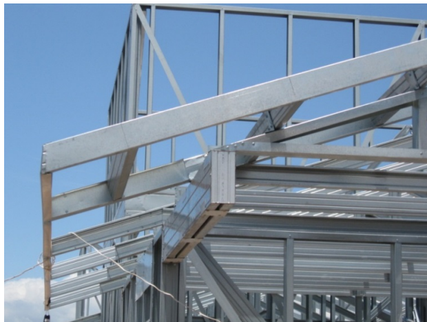
Figura 23: Detalhe de beiral
