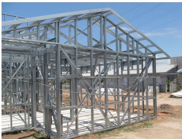
Figura 22: Tesouras fixadas sobre os painéis
