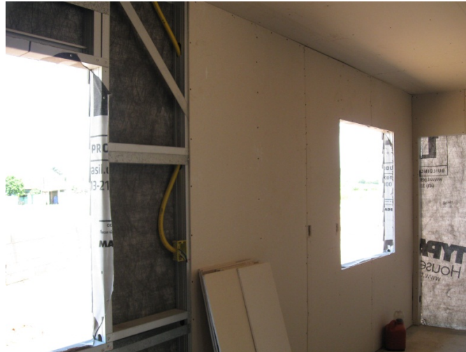
Figura 18: Placas de gesso acartonado instaladas em painel com abertura para esquadrias
