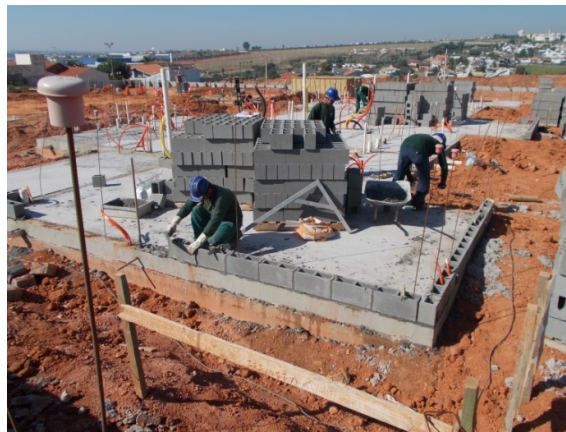
Figura 3: Canteiro de obras moderno de uma obra habitacional
