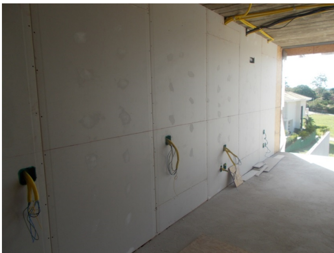
Figura 19: Placas cimentícias em painéis internos
