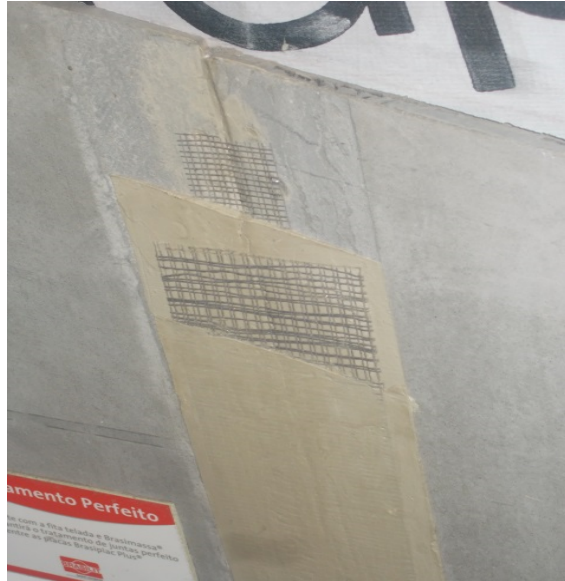
Figura 20: Exemplo de um tipo de tratamento de juntas entre placas cimentícias com elastômeros e fitas adesivas
