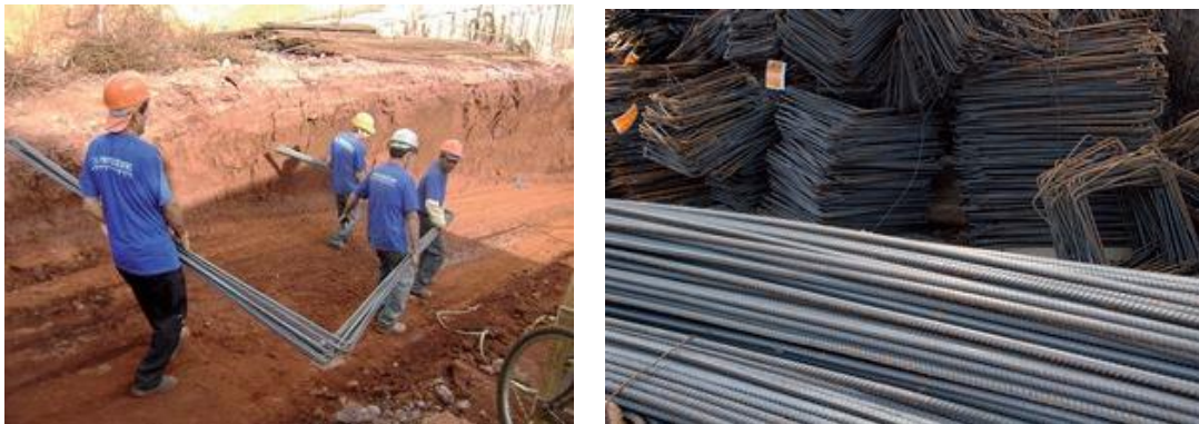
FIGURA 8 - Aço pré-cortado e pré-dobrado
