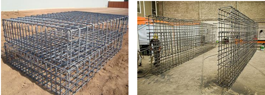
FIGURA 9 - Aço pré-montado
