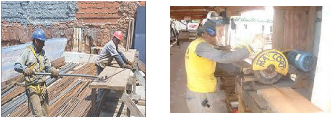
FIGURA 7 - Corte e dobra do aço na central de armação
