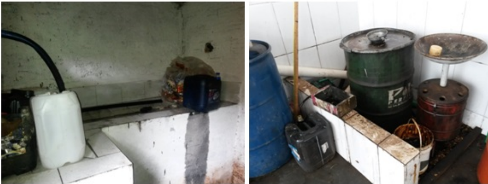
Figura 43 - à direita: depósito em alvenaria de óleo lubrificante em posto de combustível – à esquerda depósito em tambores em posto de combustível
