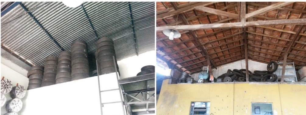
Figura 28 - Pneus armazenados, em mezanino, nos centros-automotivos
