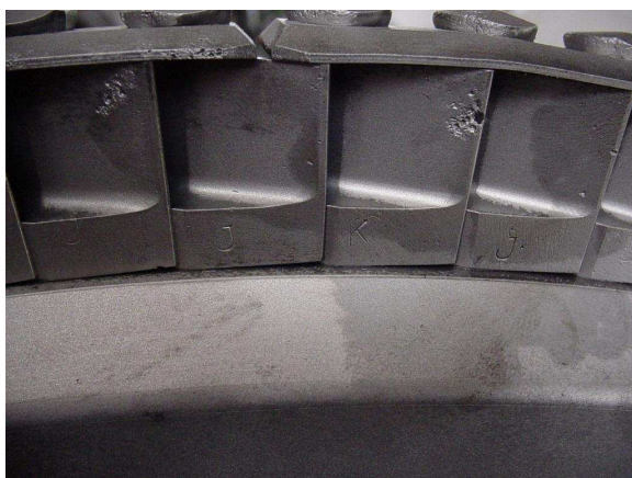
Figura 1.13 Detalhe de palhetas com desgaste erosivo.
