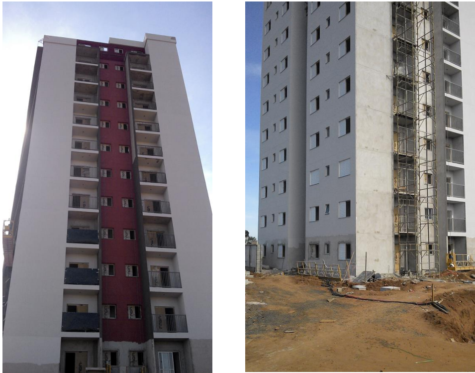
Figura 35 - Foto da obra
