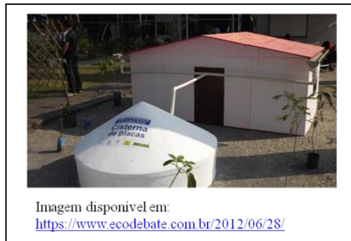
Figura 3-4 – Cisterna de Placa.
