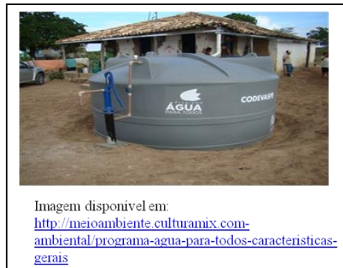
Figura 3-5 –Cisterna de Polietileno.
