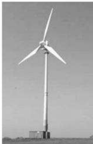
Figura 3 - Turbina Eólica de Médio Porte
