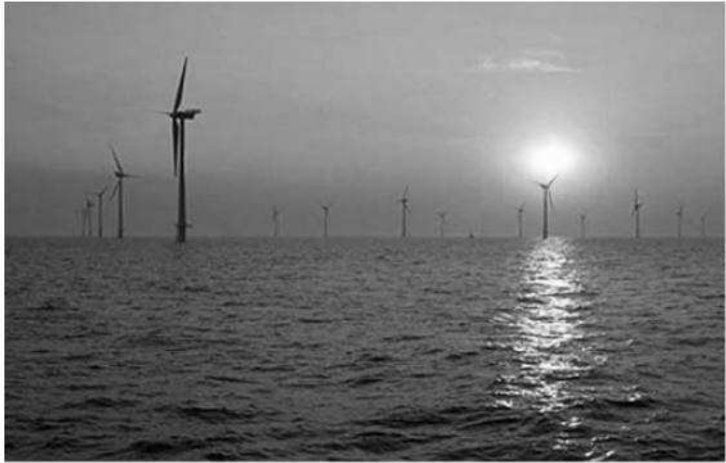
Figura 13 - Parque Eólico instalado no Mar do Norte
