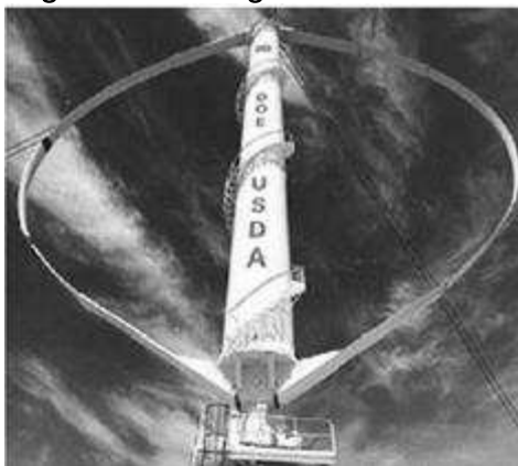
Figura 6 - Aerogerador Darrieus
