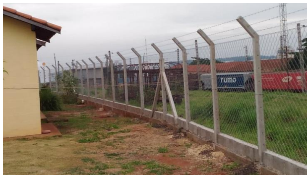
Figura 26. Fundos do Residencial, com destaque à ferrovia
