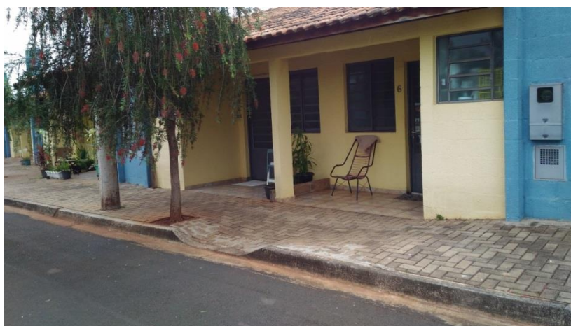
Figura 28. Rebaixamento de Calçada no Residencial Recanto Feliz
