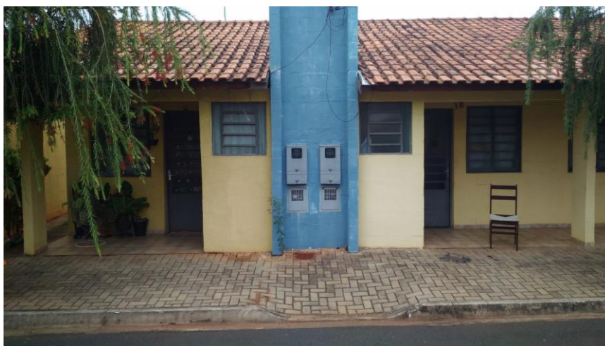
Figura 10. Fachada de duas das casas não adaptadas
