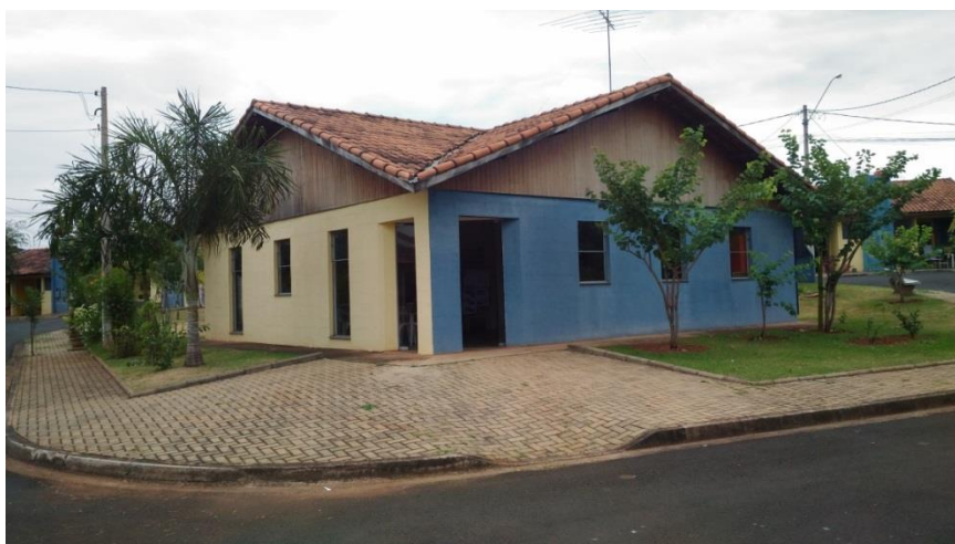
Figura 20. Fachada Centro de Convivência
