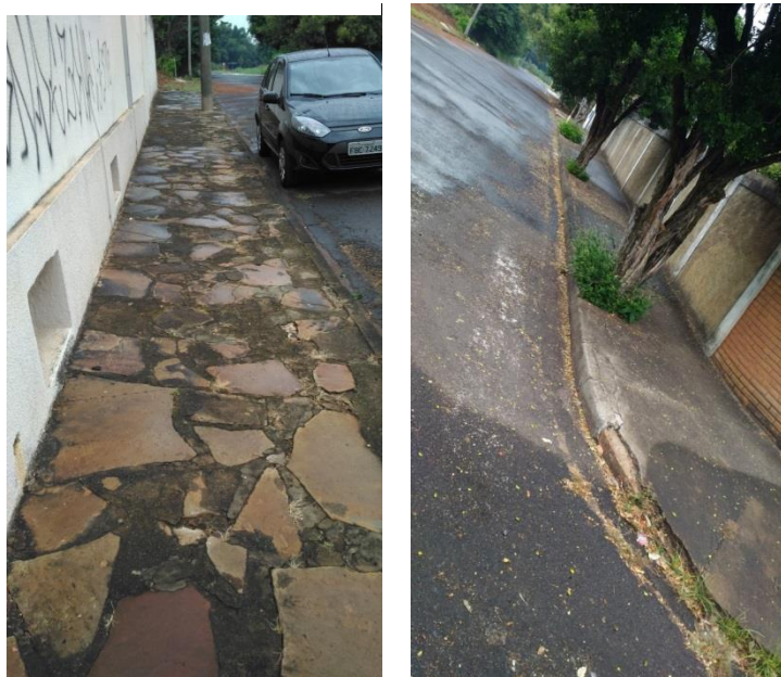
Figura 36. Calçada e Via no Entorno do Residencial Recanto Feliz
