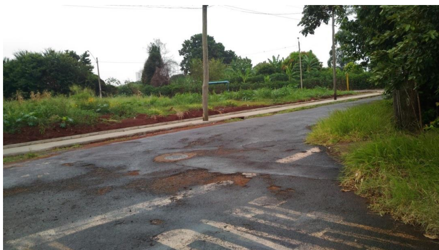
Figura 34. Calçadas e Via no Entorno do Residencial Recanto Feliz
