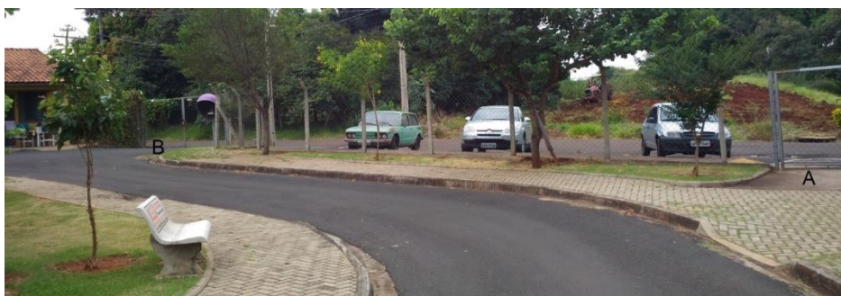
Figura 31. Acessos à Frente do Residencial
