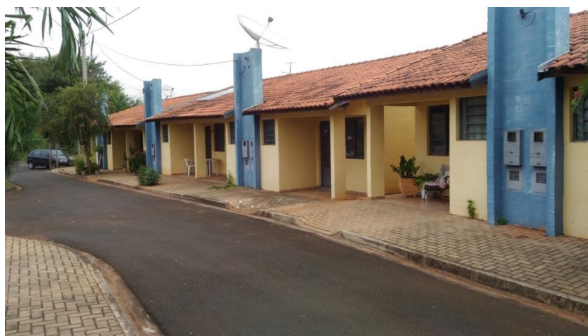
Figura 29. Rebaixamento de Calçada no Residencial Recanto Feliz
