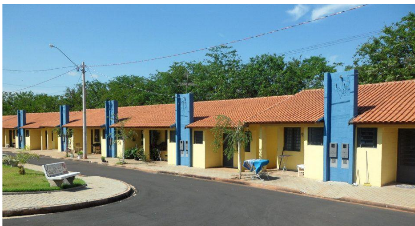
Figura 9. Vista das Casas do Residencial Recanto Feliz
