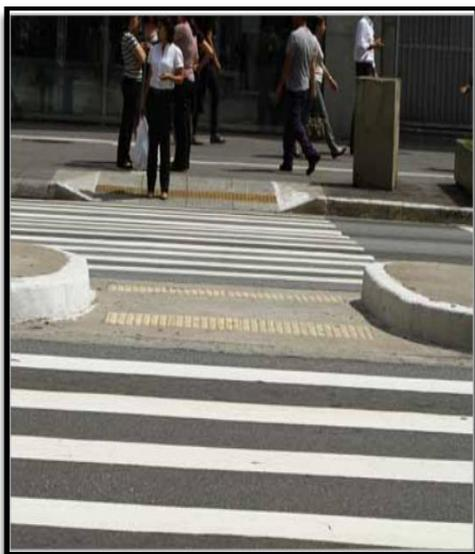
**Figura 14** - Rampa de rebaixamento da calçada
