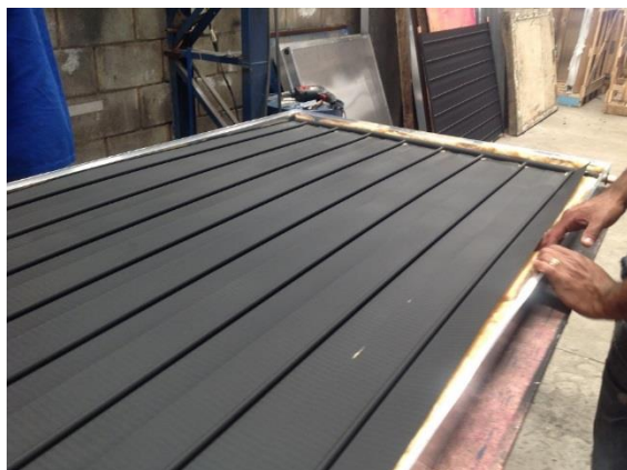
c) Montagem do conjunto absorvedor na caixa do coletor
