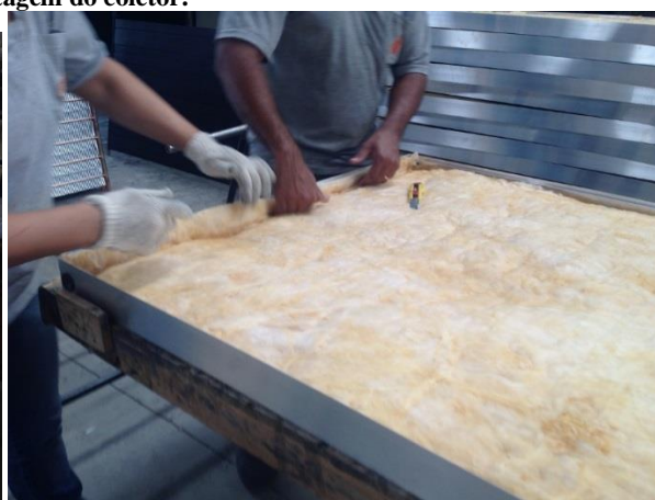
b) Montagem do isolante térmico e vedações
