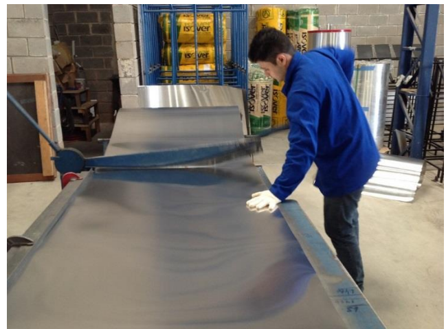
d) Corte chapa de fundo do coletor
