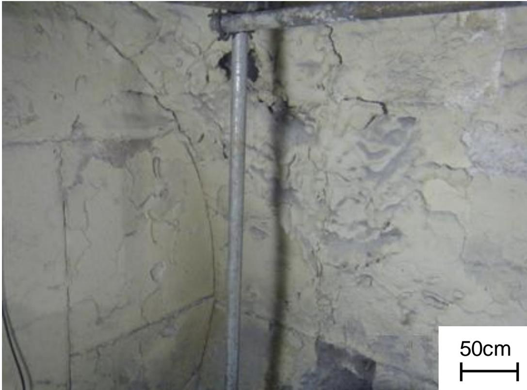
Figura 6.12- Áreas com refratários danificados na parte inferior do Forno,
