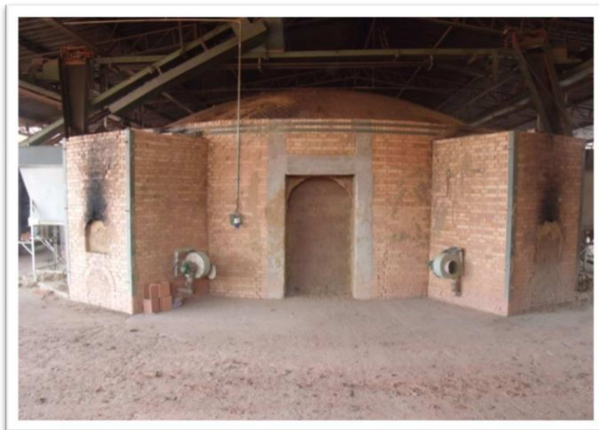
Figura 13: Forno Abóboda com Alimentação Automatizada. Para serragem e cavacos de madeira.
