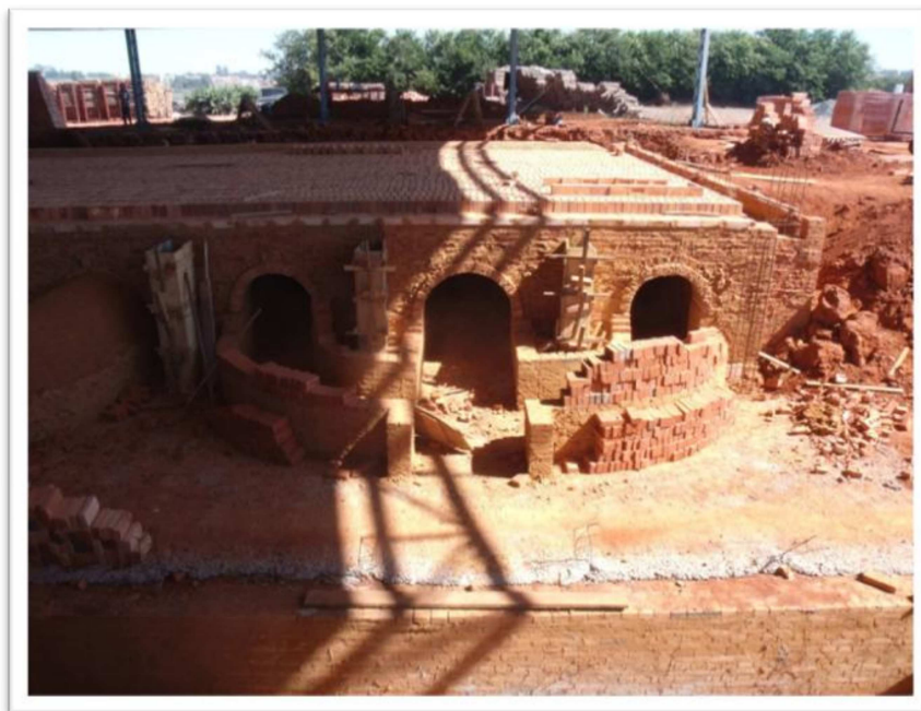
Figura 12: Forno Abóboda sendo Construído. E suas galerias para recirculação do ar quente
