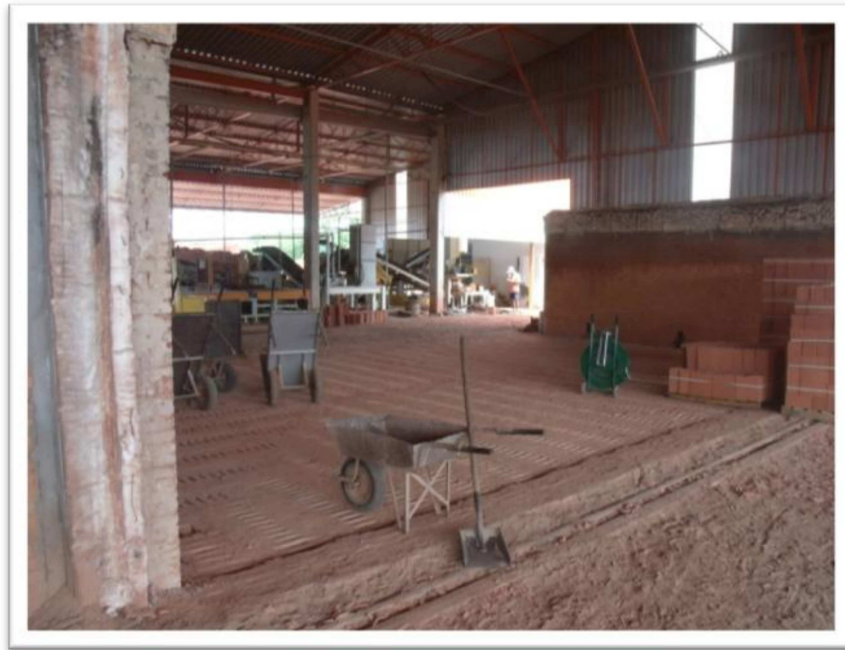
Figura 16: Vista do Forno Túnel sobre Trilhos Descarregado.
