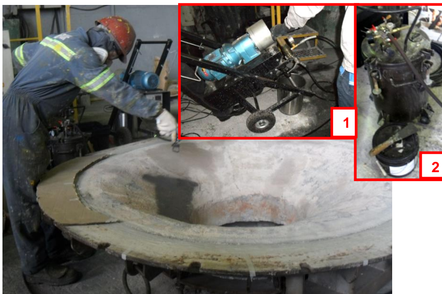
Figura 4. 17. Aplicação da tinta EM04 na tampa do cadinho. No detalhe 1 observa-se a bomba utilizada para aplicar a tinta e no detalhe 2, o misturador utilizado.
