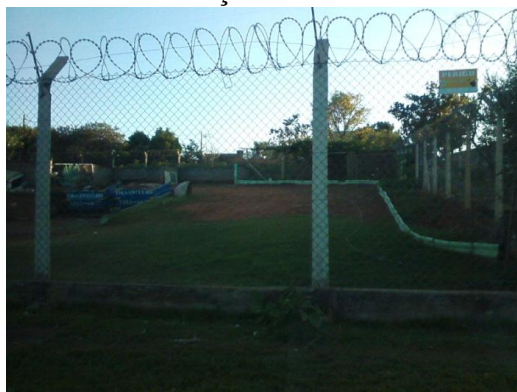
Figura 27 - Ecoporto Regional Pacaembu: local cercado, com cerca elétrica, existências de caçambas.
