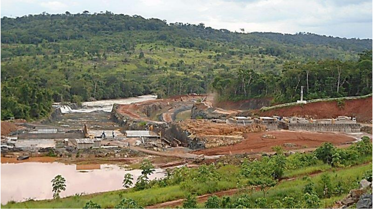
Figura 13: PCH CACHIMBO ALTO (EM CONSTRUÇÃO)
