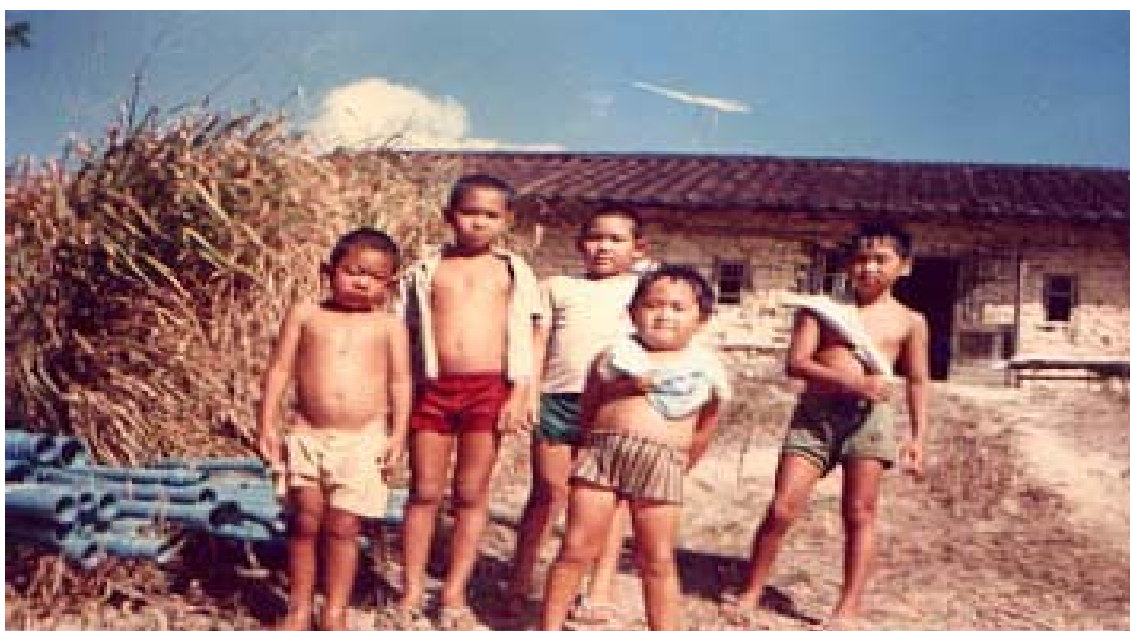
Figura 8 - Núcleo JK - Aspecto após a construção da mesma residência.
