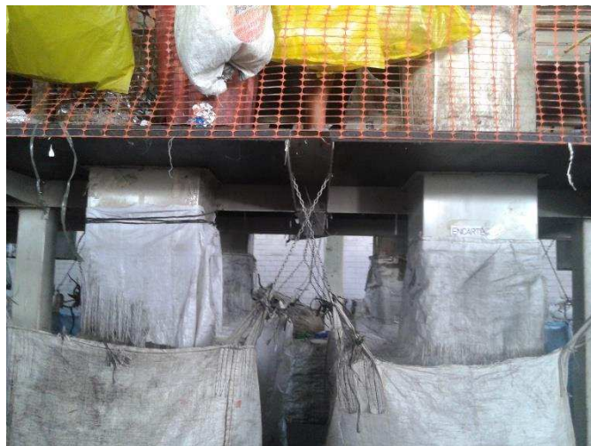
FIGURA 8 – Canaletas plásticas nos buracos da esteira.
