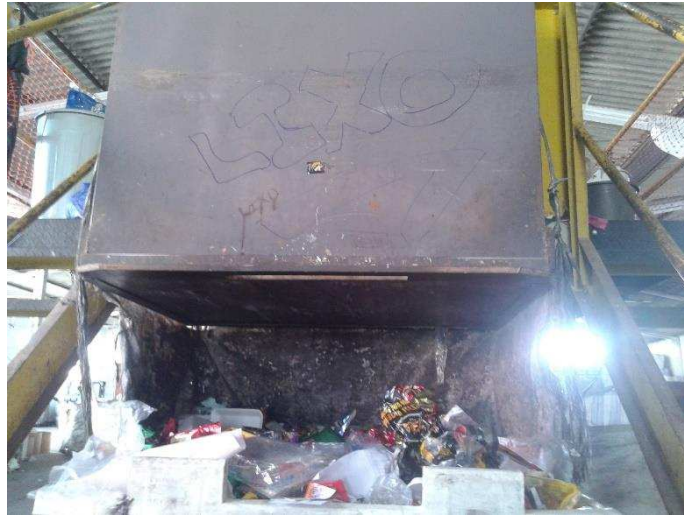
FIGURA 7 – Canaleta de metal no final da esteira
