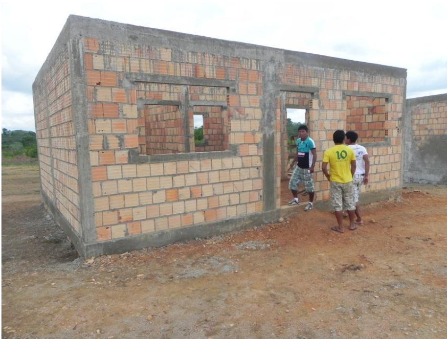
Figura 31. Construção das casas de alvenaria na aldeia Rap Kô. Foto: Arquivo pessoal da autora.
