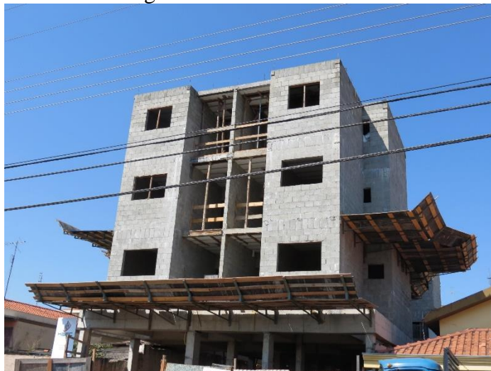
Figura 29 - Vista da Obra E
