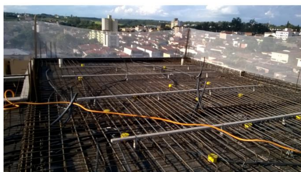
c) Laje pronta pra concretagem – laje maciça
