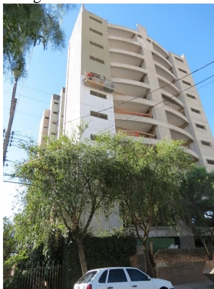
Figura 25 - Vista da Obra A
