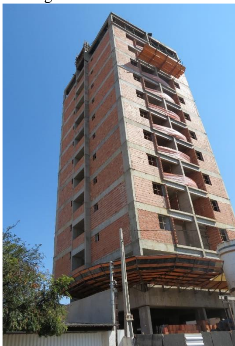
Figura 27 - Vista da Obra C
