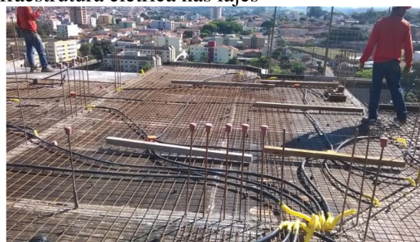
b) Caixas de PVC e eletrodutos colocados e fixados
