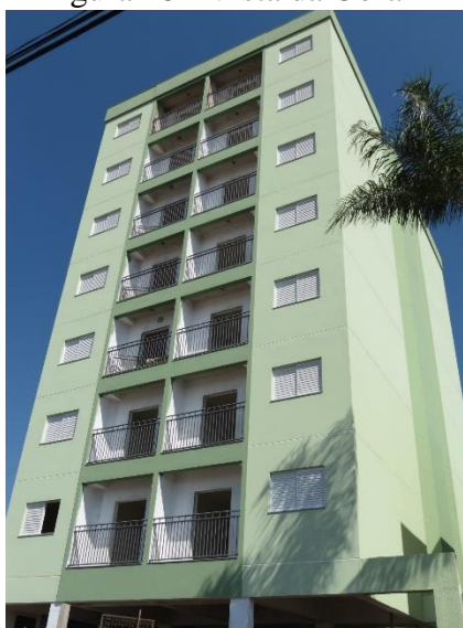
Figura 28 - Vista da Obra D
