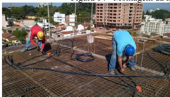
a) Colocação dos eletrodutos nas caixas de PVC
