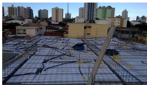
d) Laje pronta pra concretagem – laje pré-moldada
