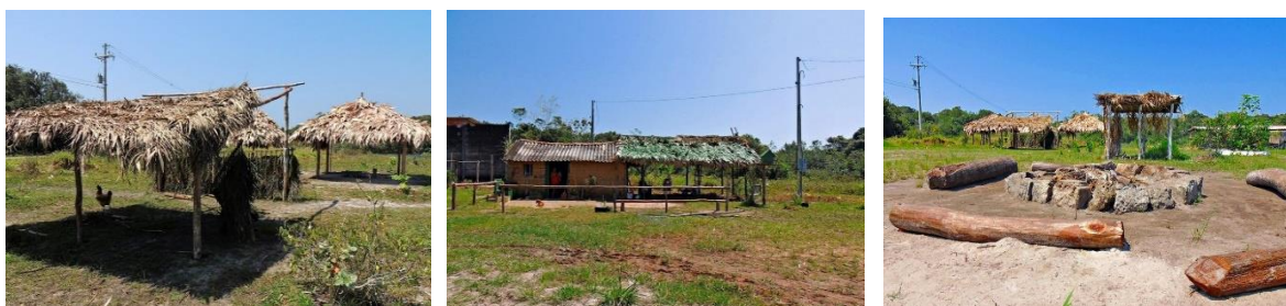
Figura 25 – Construção de novas estruturas na Aldeia Tabaçu Reko Ypy , Itanhaém-Peruíbe/SP.
