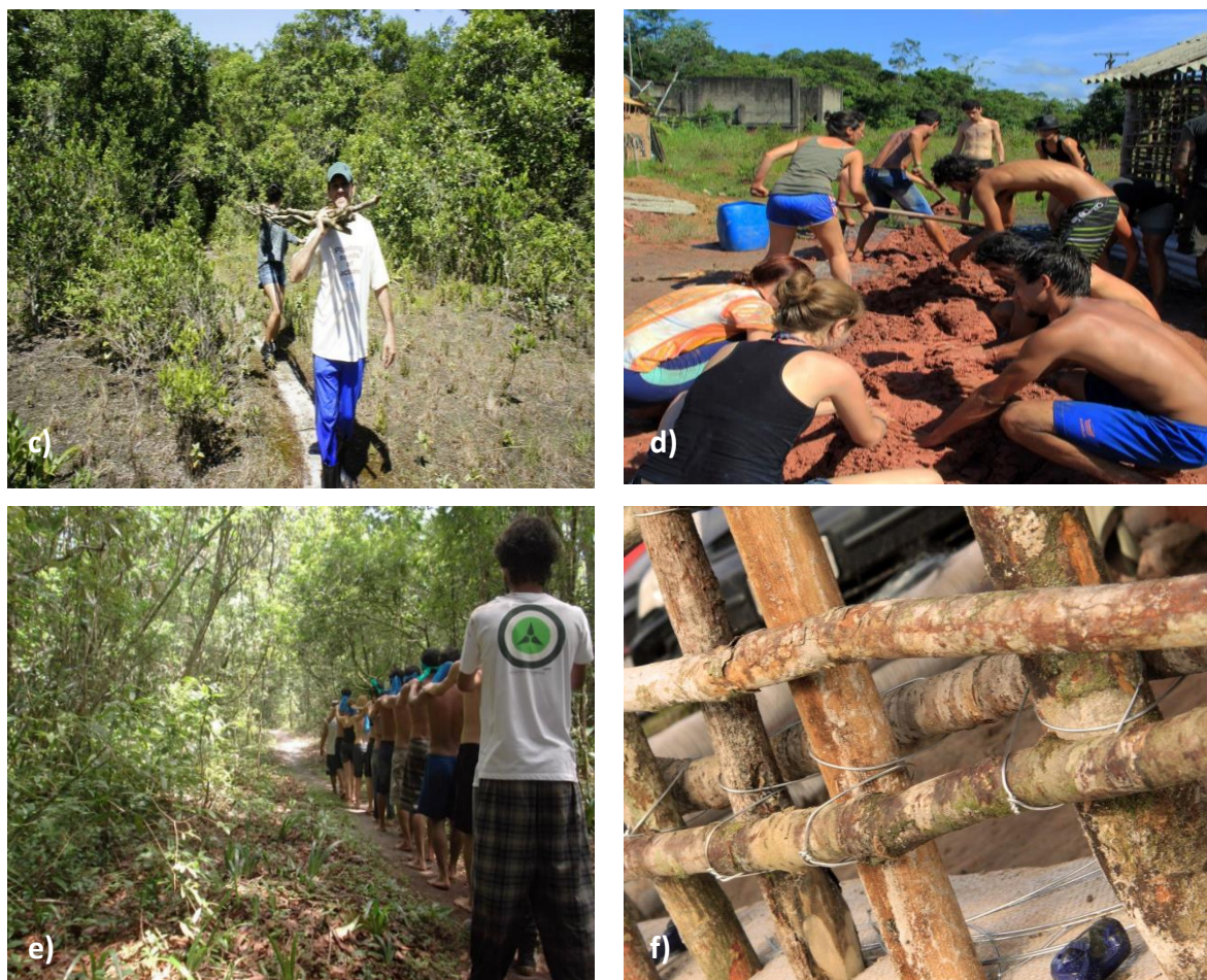
Figura 16 – c) Grupo 1 coletando madeira. d) Preparação da argila para barrear as casas. e) Grupo 3 em atividades sensoriais ambientais – trilha sensitiva. f) Gradeamento pronto para receber a técnica de barreamento. Aldeia Tabaçu Reko Ypy Itanhaém-Peruíbe/SP .
