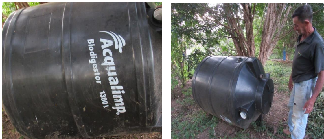
Figuras 28 e 29 - Biodigestor para tratamento de efluente
