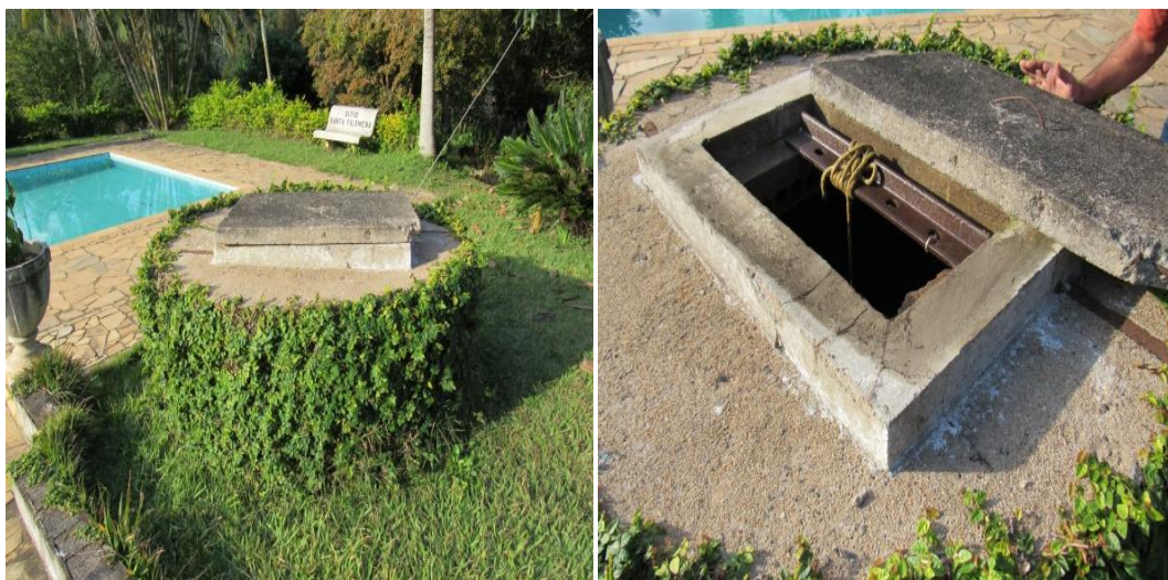
Figuras 16 e 17 - Cisternas ou poços verticais para abastecimento da residência
