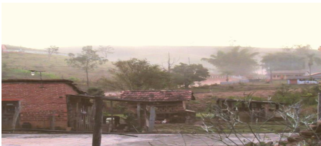
Figura 30 - Baias de suínos desativadas às margens de manancial hídrico
