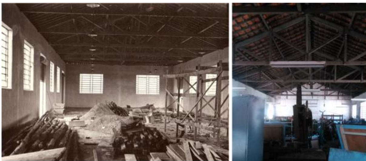
Figura 48: Vista interna do pavilhão em construção na década de 1950 (esquerda); vista atual do pavilhão em 2016 (direita).
