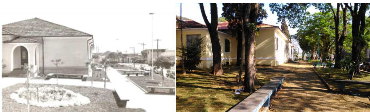
Figura 46: Entrada lateral esquerda do “Prédio Velho” na década de 1950 (esquerda); entrada atual, em 2016 (direita).
