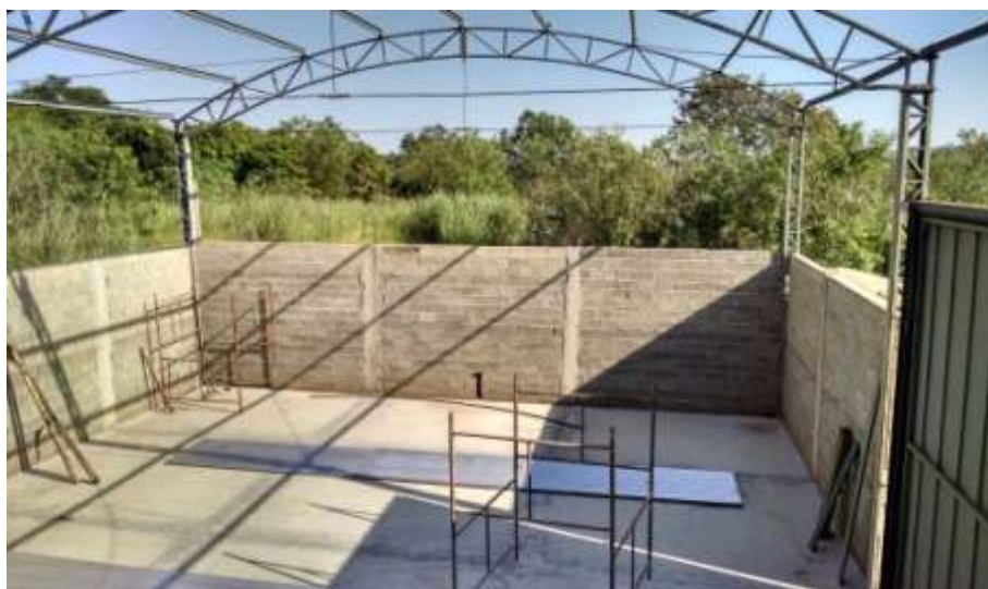
Figura 13 – Barracão de comercialização em construção
