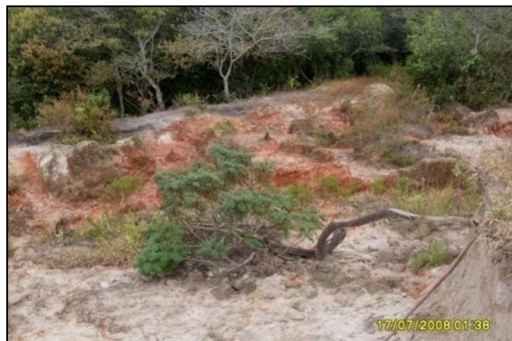
Figura 26: Erosão na Comunidade do Cedro Autor: Jesiel Silva
