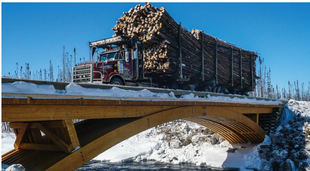
Figura 1.5: Ponte rodoviária em Québec, Canadá [Fonte: http://nordic.ca/en/projects/structures/temiscamie-river-bridge ]
