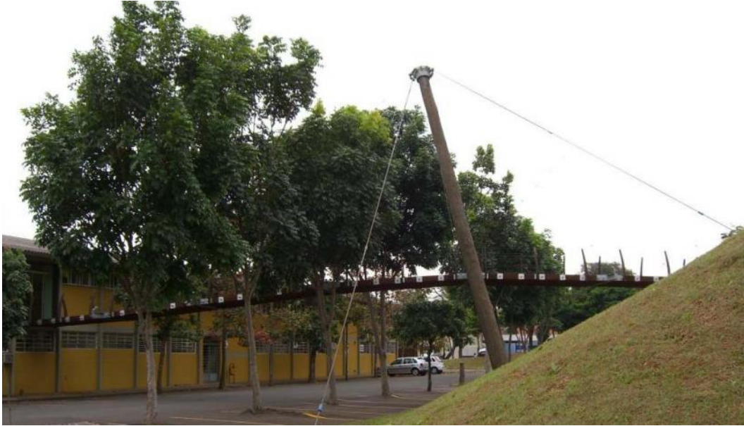
Figura 1.4: Exemplo de uma passarela estaiada executada em estrutura de madeira no Brasil [Fonte: SEGUNDINHO (2010)]
