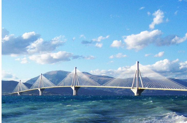
Figura 2.2 - Ponte Rion-Antirion, Grécia. Localizada em ambiente marinho e projetada para uma vida útil de 120 anos (Fonte: http://migre.me/wnbP1 ).
