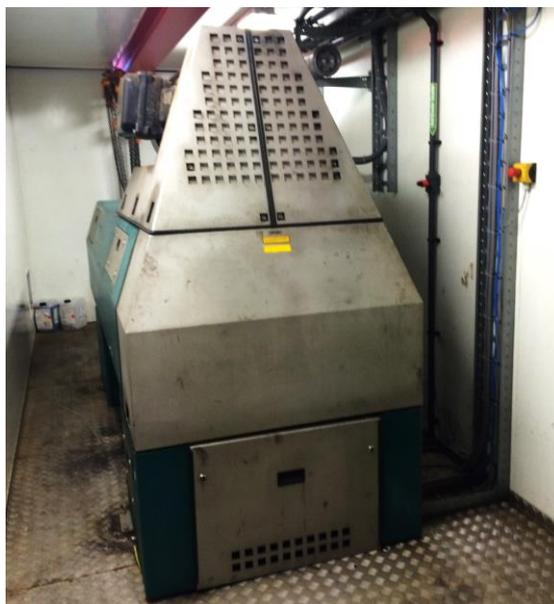
**Figura 5.11** – Centrífuga utilizada para desaguar o lodo afluyente ao processo de biossecagem.
