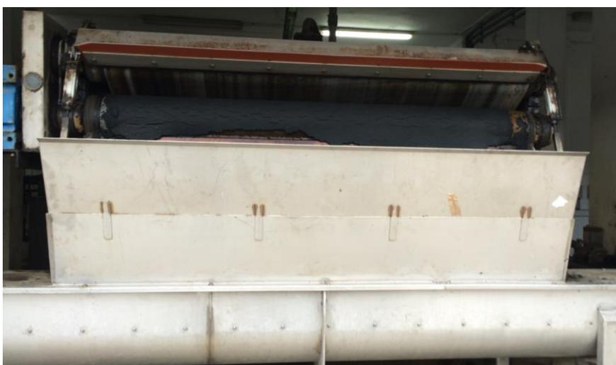
**Figura 5.5** – Lodo efluente ao filtro prensa de correia.
