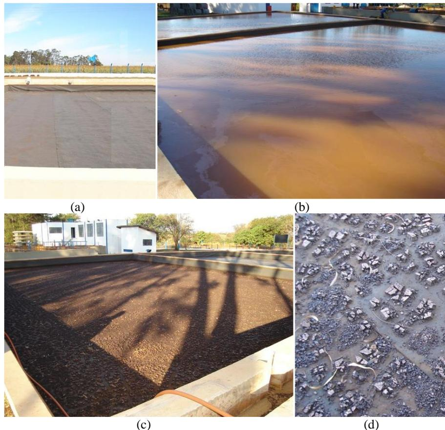
**Figura 3.34** – Leito de drenagem ETA de Guaíra-SP: (a) disposição da manta geotêxtil; (b) leitos cheios; (c) leito de drenagem com lodo desaguado; (d) lodo “seco”.
