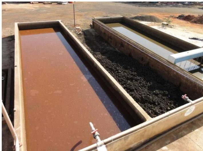
**Figura 3.8** – Leitos de secagem – ETA de Nova Odessa-SP.
