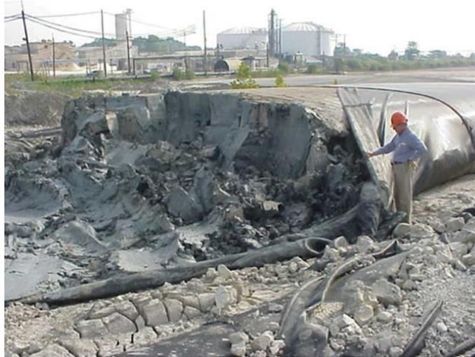
**Figura 3.14** – Corte do tecido para remoção dos sólidos de um bag.
