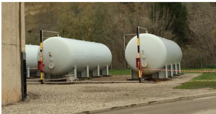
**Figura 5.6** – Dois dos três tanques de armazenamento de biogás, ao lado do digestor anaeróbio.
