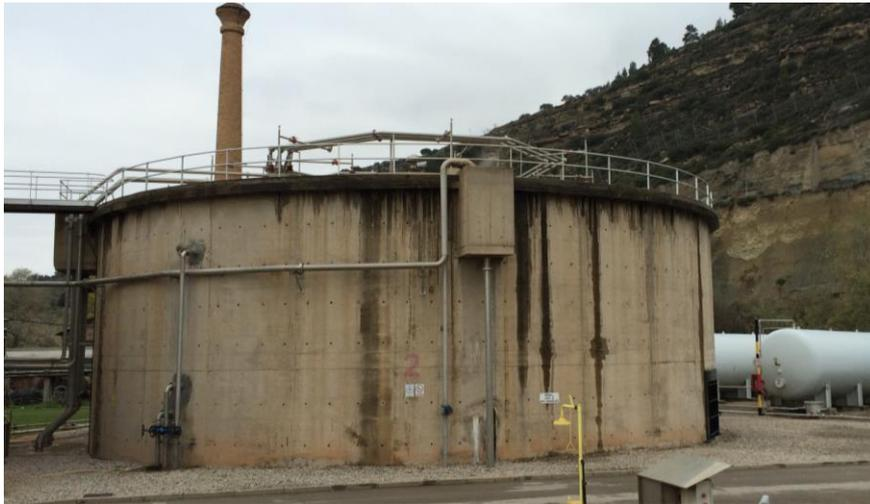
**Figura 5.2** – Digestor anaeróbio da ETE de Manresa.
