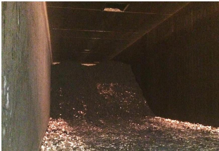
**Figura 5.15** – Interior de um reator de biossecagem com preenchimento parcial de mistura lodo:estruturantes.
