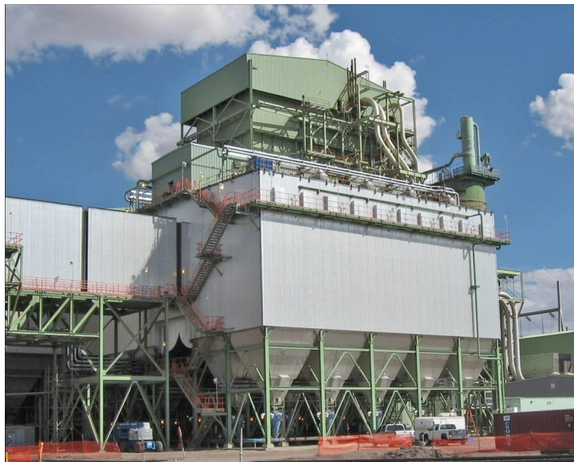
Figura 5 – Fotografia de um filtro de mangas com sistema de limpeza por jato de ar pulsante.
