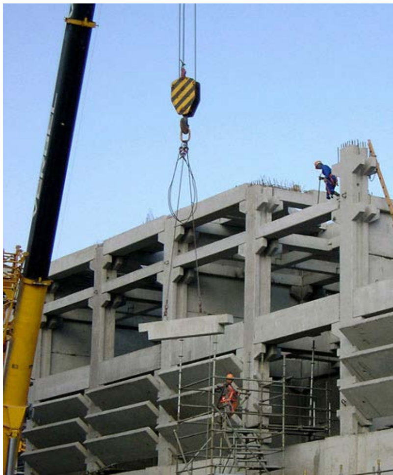
Figura 2-12 - Içamento de viga pré-fabricada
