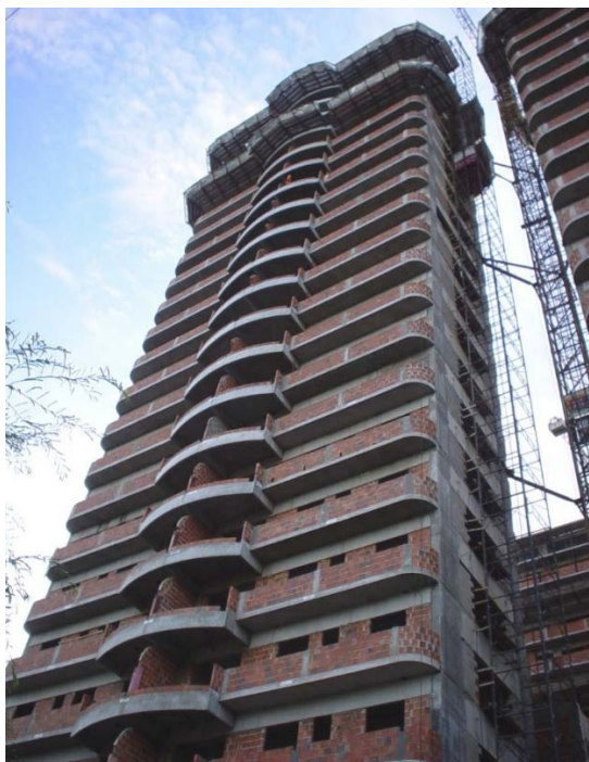
Figura 3-45 - Construção do Shopping
