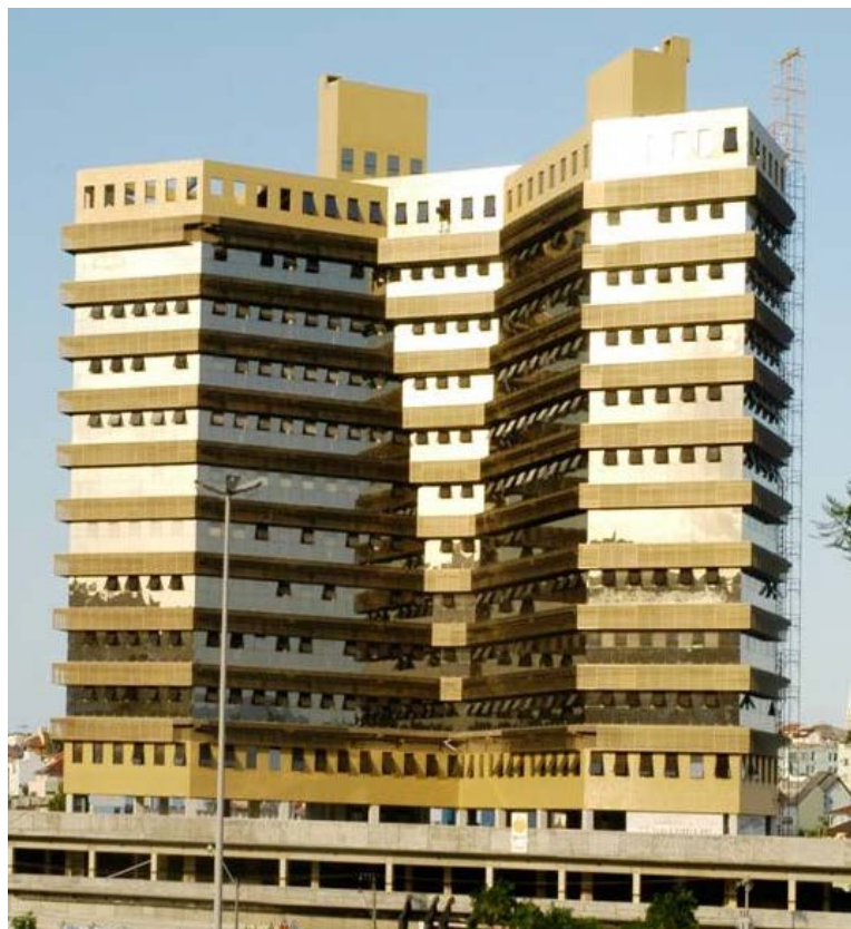
Figura 3-3 - Edifício no Brasil com sistema construtivo híbrido
