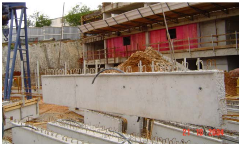
Figura 3-23 - Içamento da viga pré-moldada
