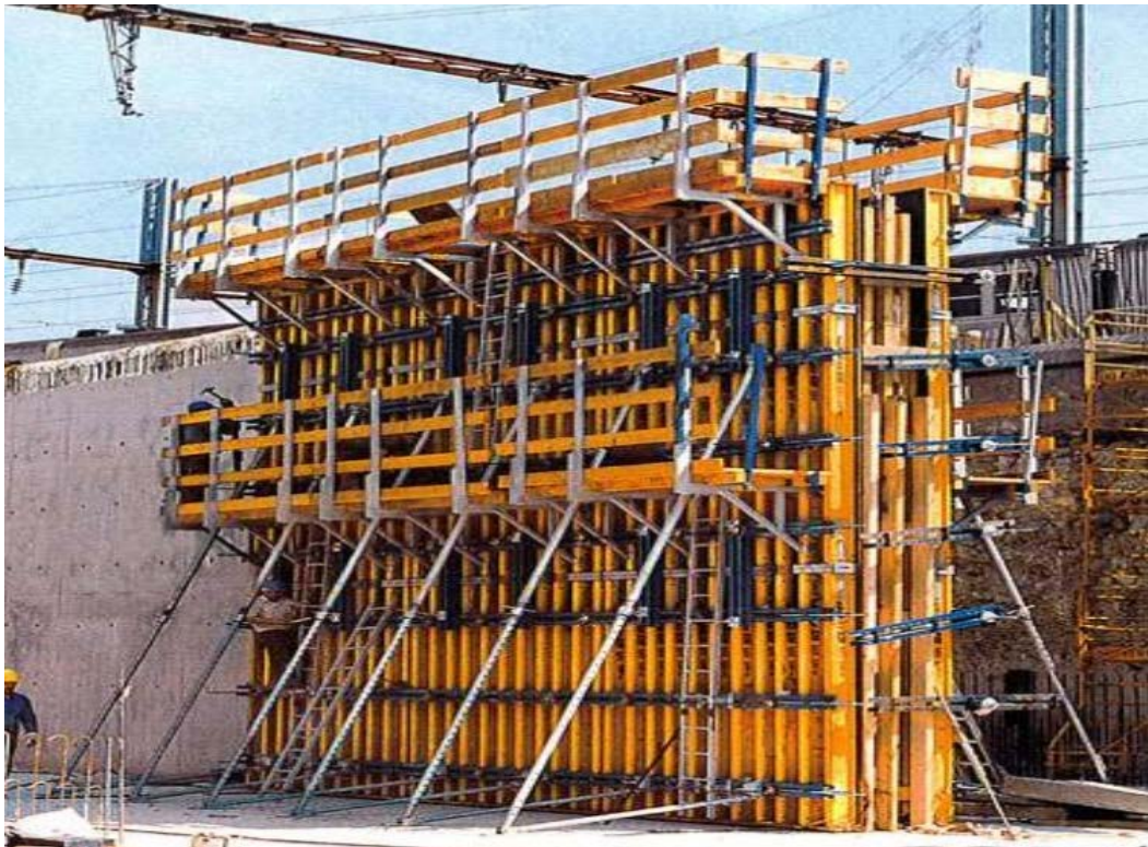
Figura 2-32 - Sistema de fôrmas utilizado no Burj Khalifa
