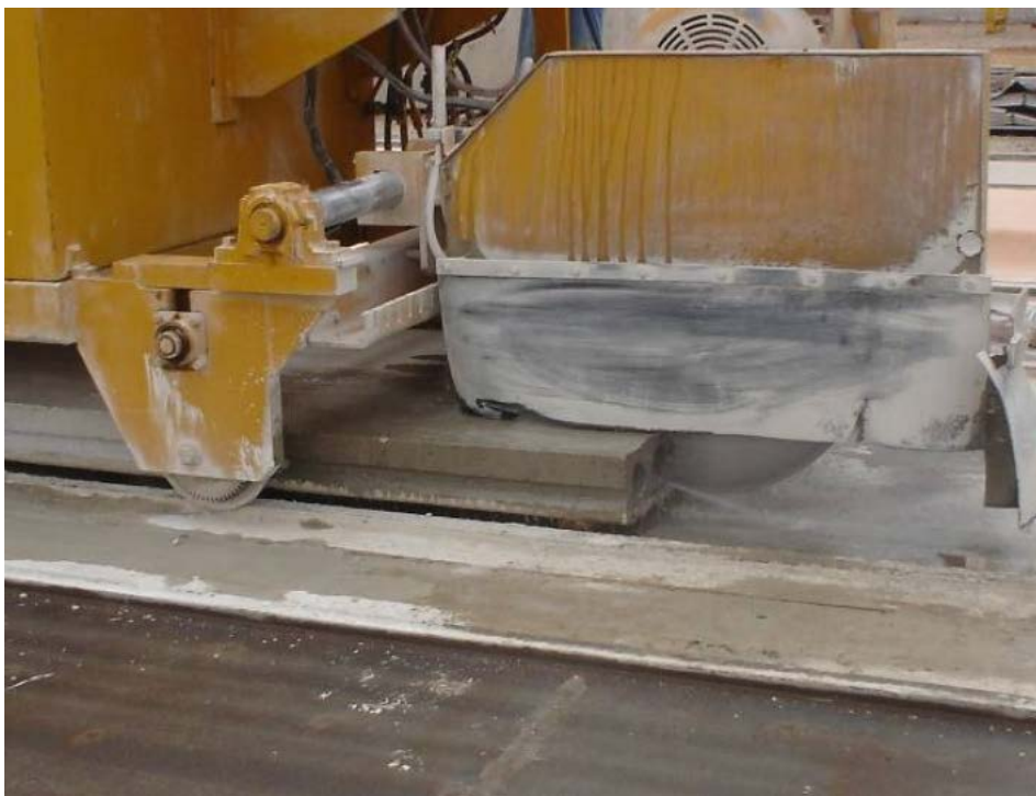
Figura 2-38 - Corte das lajes na pista de protensão
