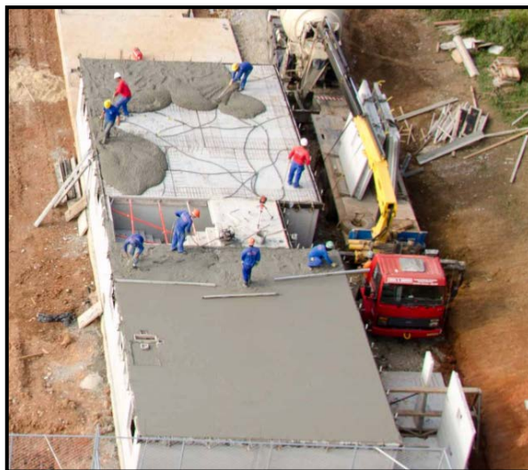
Figura 3-27 - Capeamento das lajes
