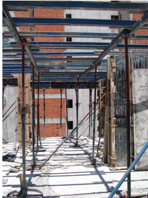
Figura 2-28 - Posicionamento das escoras da laje
