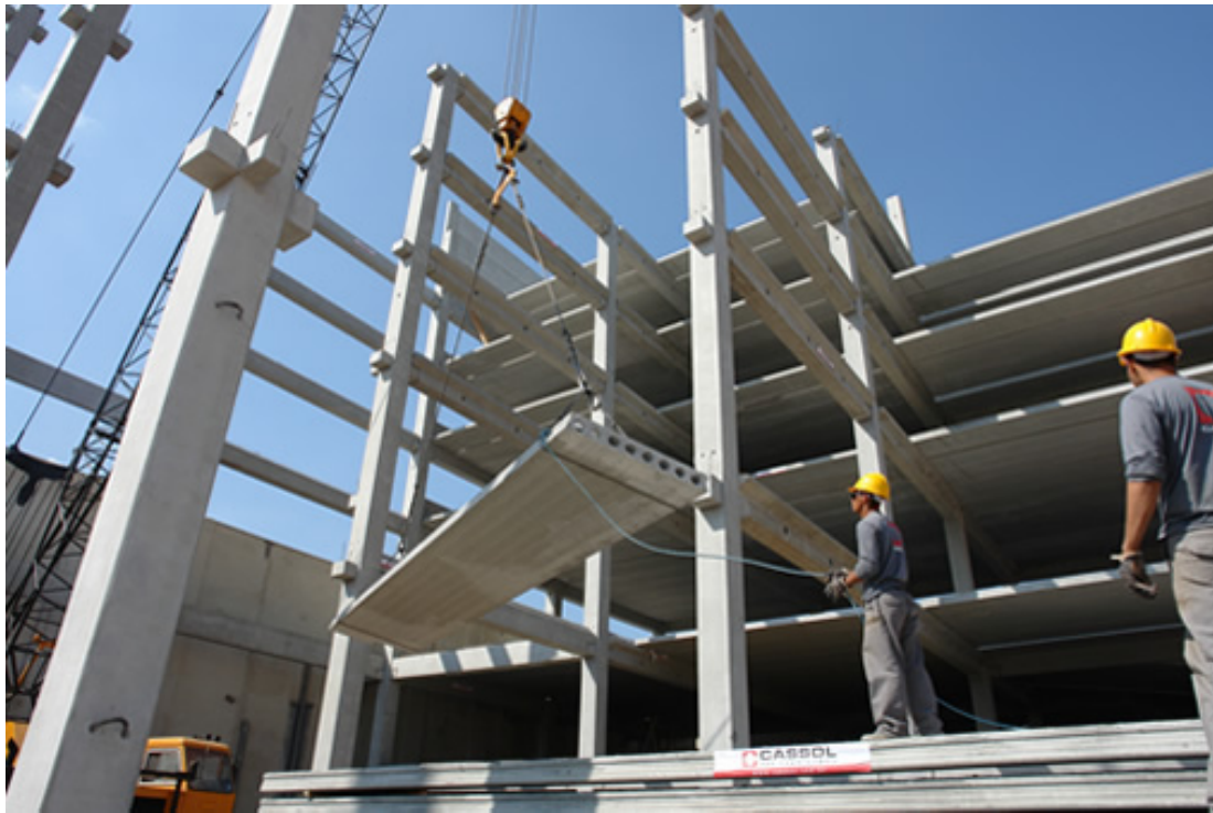
Figura 2-14 - Içamento de laje alveolar
