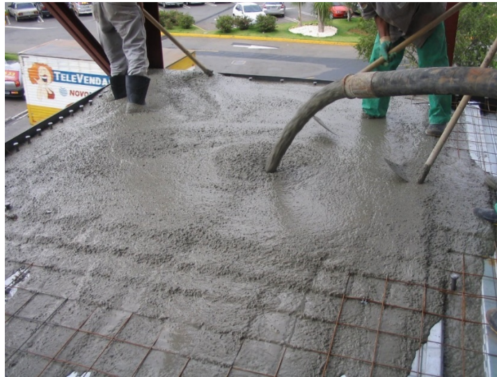
Figura 3-19 - Lançamento do concreto auto adensável, não há a necessidade do uso de vibradores de imersão
