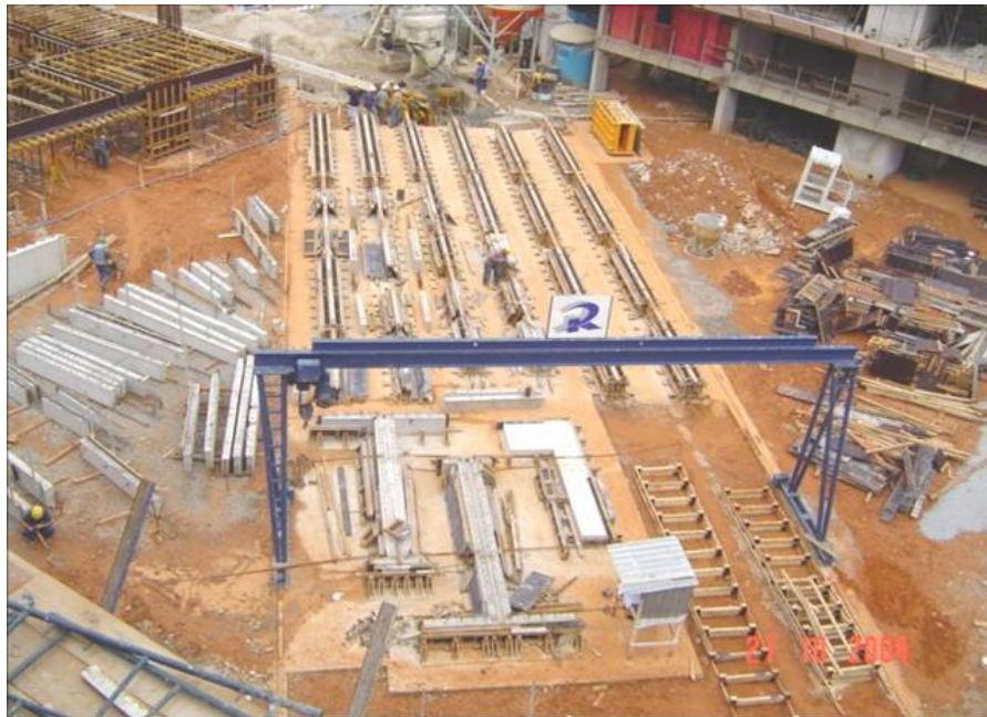
Figura 3-20 - Montagem de pórtico no próprio canteiro
