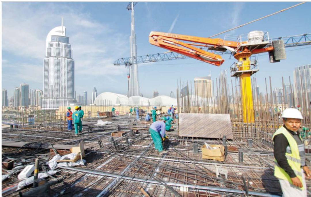
Figura 2-30 - Construção do Burj Khalifa no sistema construtivo moldado no local
