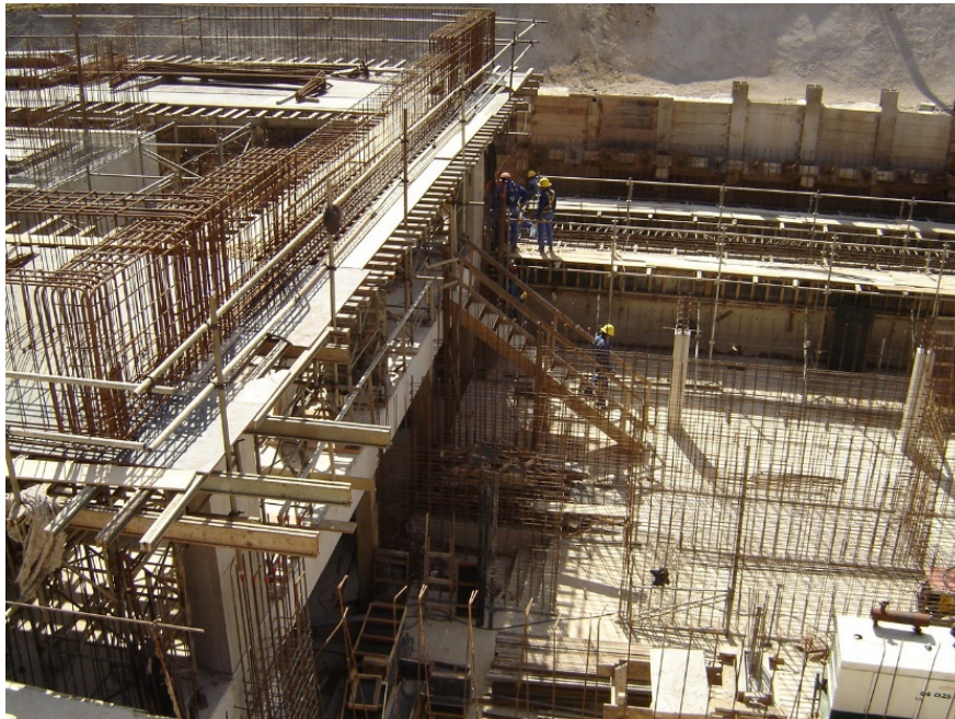
Figura 2-23 - Armadura e escoramentos em canteiro do sistema moldado no local
