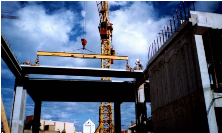
Figura 3-31 - Içamento e posicionamento das lajes alveolares pré-fabricadas
