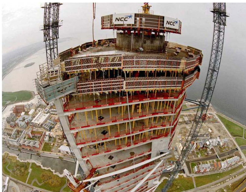
Figura 3-34 - Construção do Turning Torso
