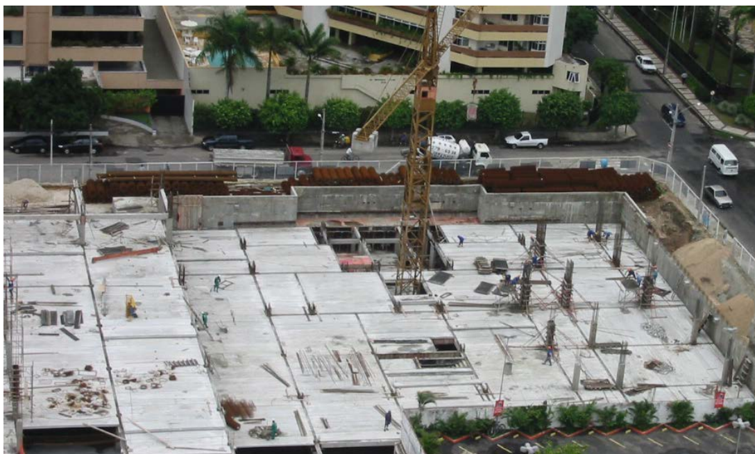
Figura 3-46 - Panorama do canteiro de obras
