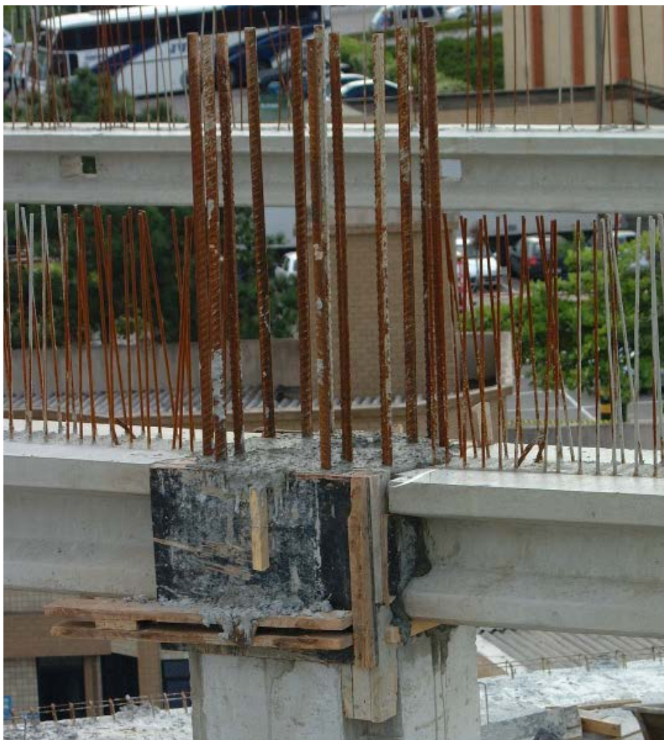
Figura 3-30 - Concretagem da ligação viga pilar
