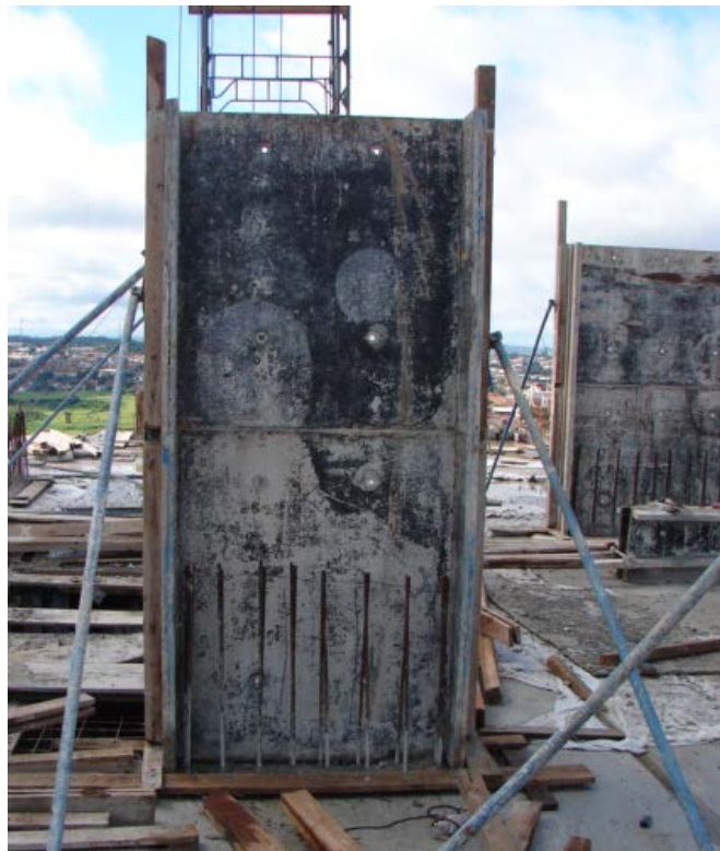
Figura 2-26 - Posicionamento das fôrmas dos pilares
