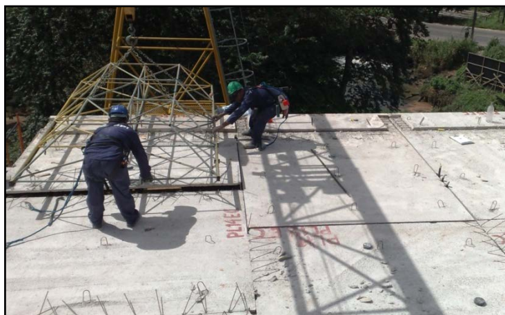
Figura 3-26 - Posicionamento das lajes no local definitivo
