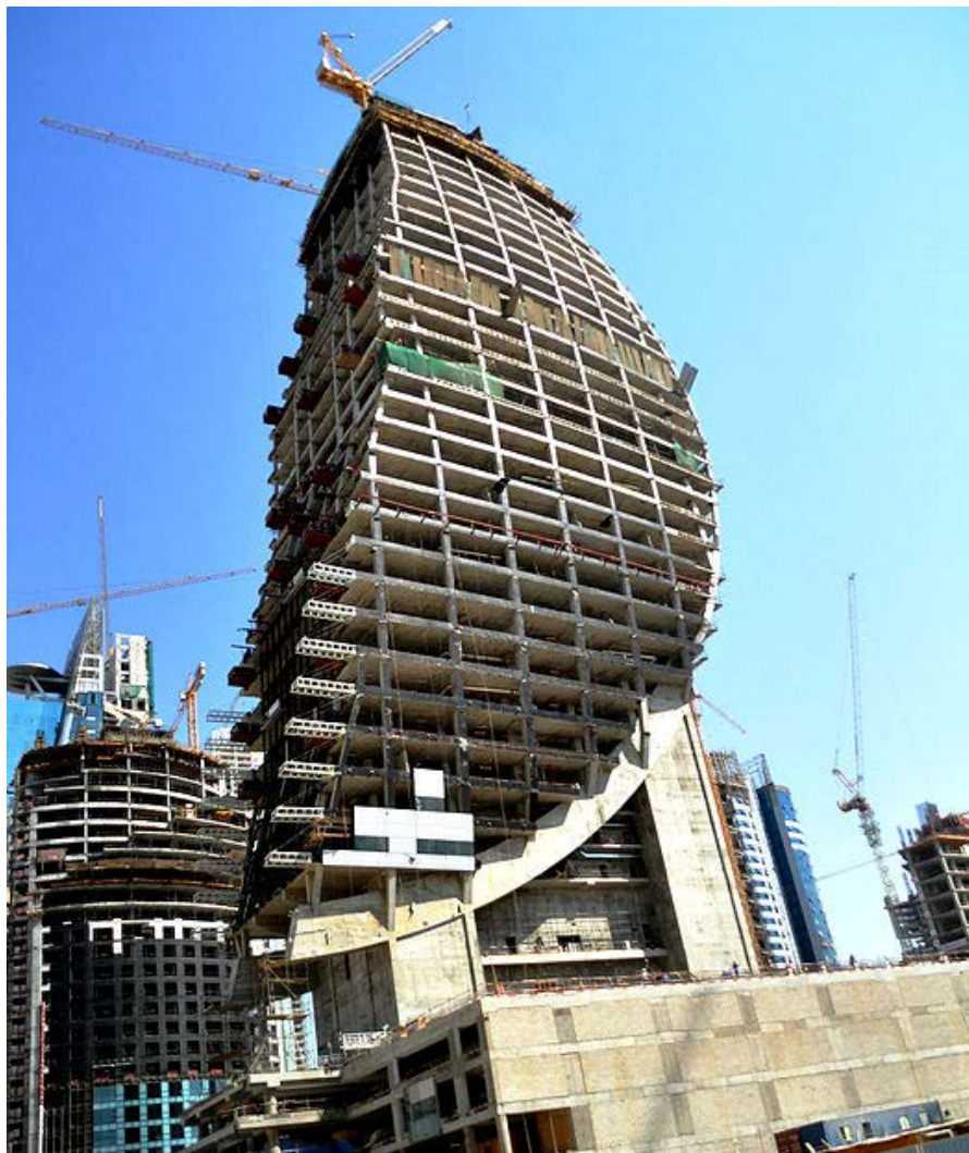
Figura 3-1 - Estrutura em sistema construtivo híbrido
