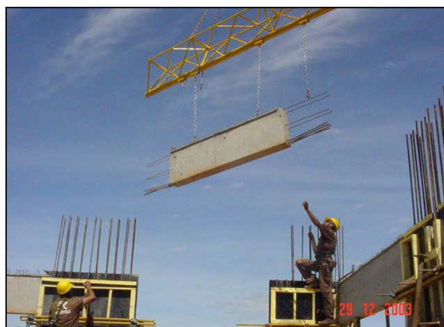
Figura 3-24 - Posicionamento da viga no local definitivo
