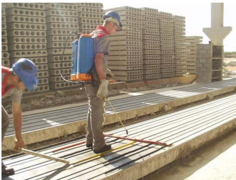
Figura 2-35 - Preparação da pista de protensão
