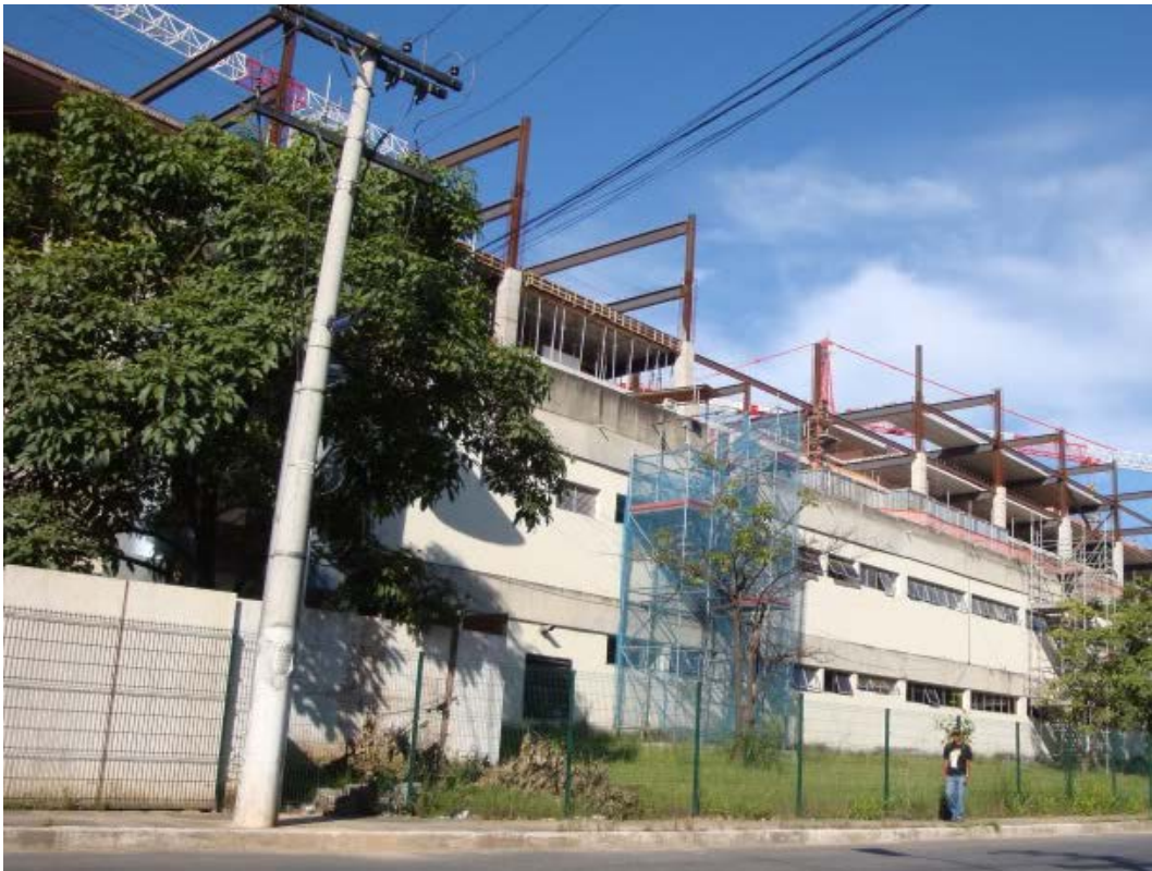
Figura 2-1 - Estrutura mista de aço e concreto
