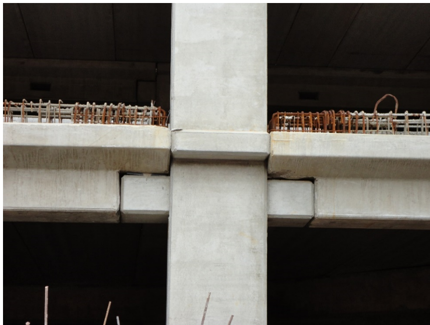
Figura 2-19 - Ligação viga x pilar pré-fabricado
