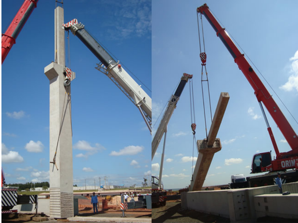
Figura 2-11 - Içamento do pilar pré-fabricado
