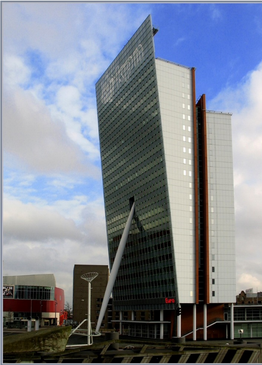
Figura 3-41 - Edifício KPN Tower
