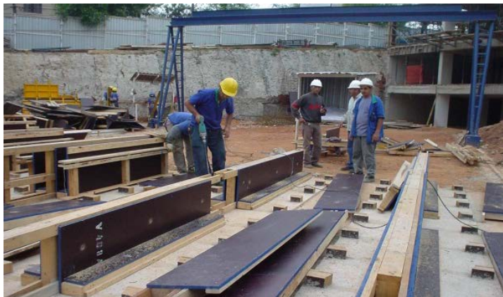
Figura 3-21 - Montagem das fôrmas para pré-moldagem no canteiro
