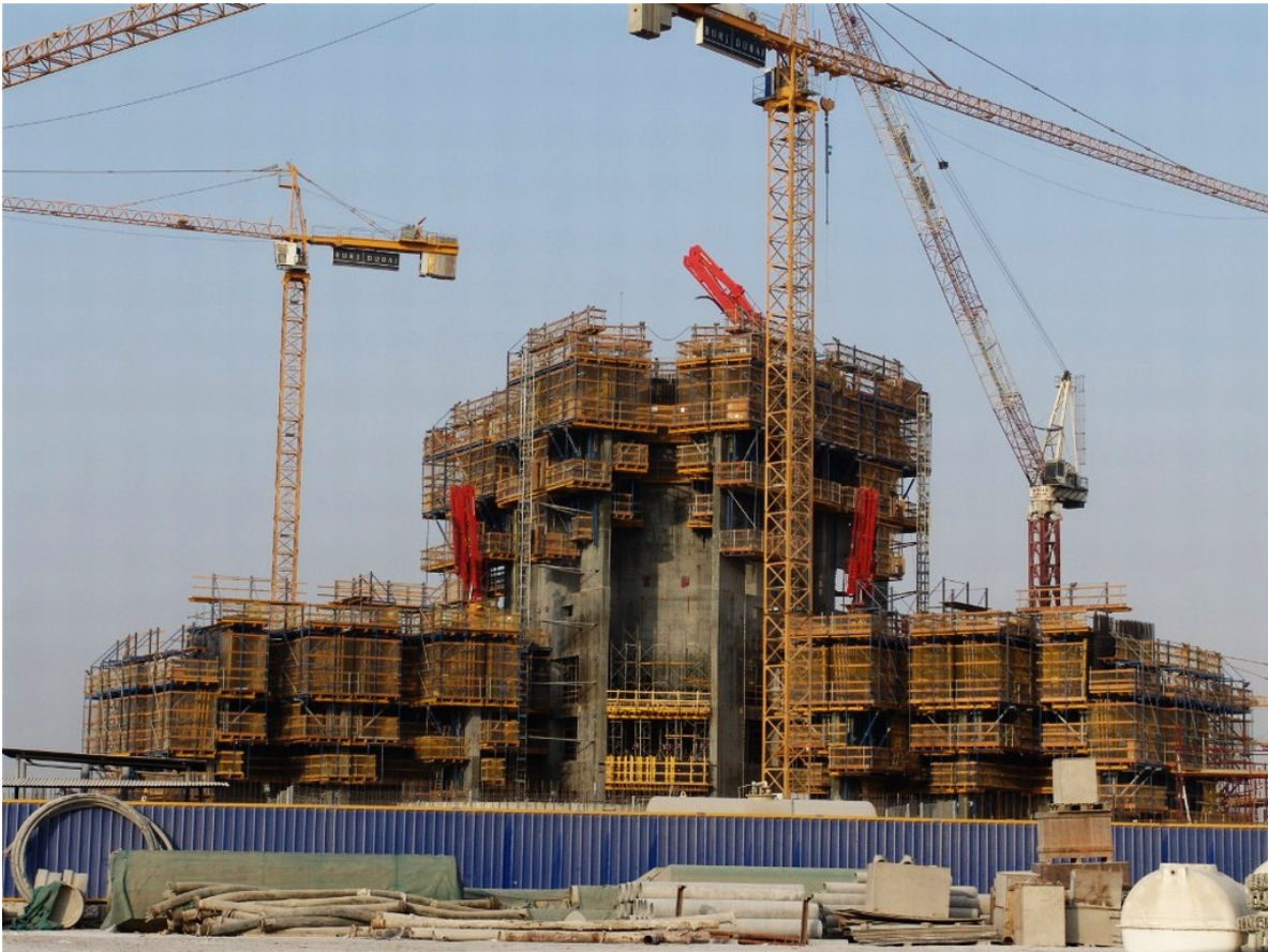
Figura 2-31 - Sistema de fôrmas do Burj Khalifa
