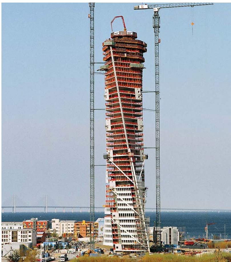
Figura 3-36 – Construção do Turning Torso
