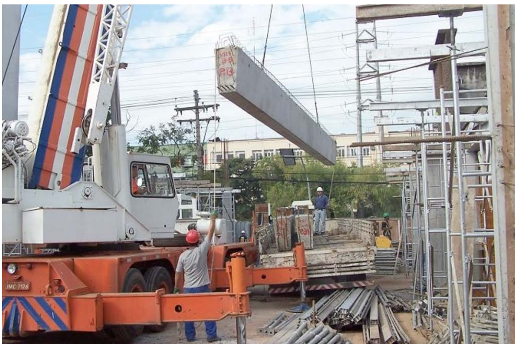
Figura 2-9 - Içamento de uma viga pré-moldada
