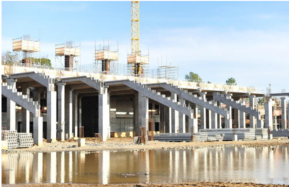
Figura 2-6 - Estrutura em concreto pré-fabricado
