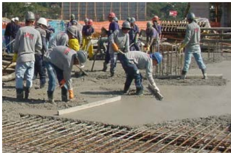
Figura 2-22 - Elevado número de funcionários no canteiro de obras na concretagem
