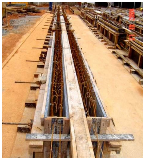
Figura 3-22 - Posicionamento da armadura nas fôrmas para pré-moldagem das vigas
