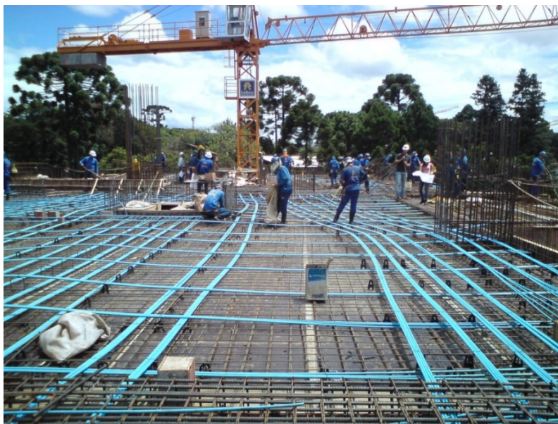
Figura 2-34 - Construção de um pavimento em concreto protendido
