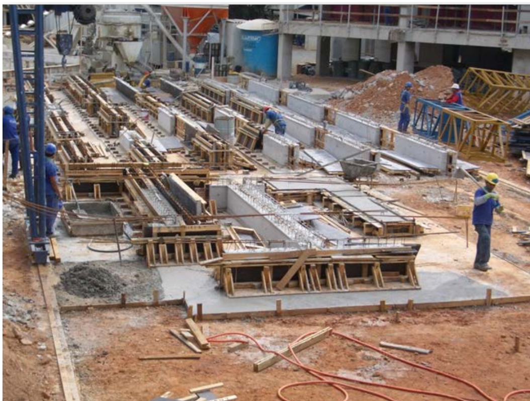
Figura 3-12 - Pré-moldagem no canteiro de obras
