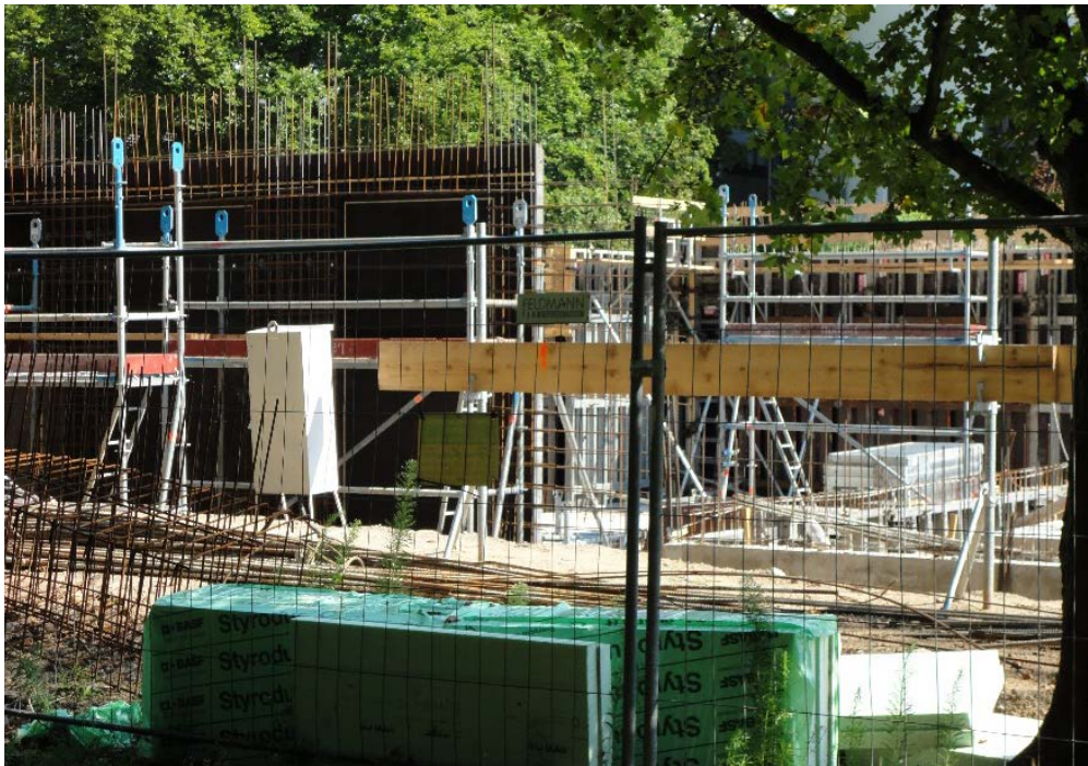
Figura 2-20 - Sistema construtivo moldado no local na Alemanha
