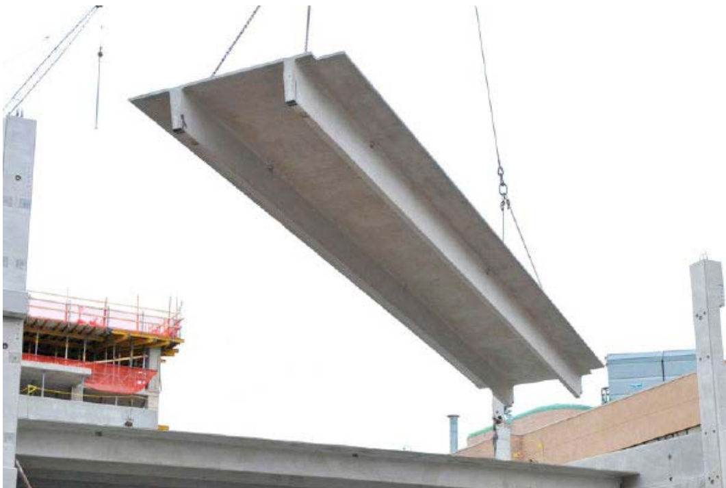
Figura 2-15 - Içamento de laje Pi
