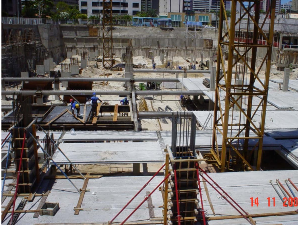
Figura 3-47 - Pilares moldados no local com vigas e lajes pré-fabricadas
