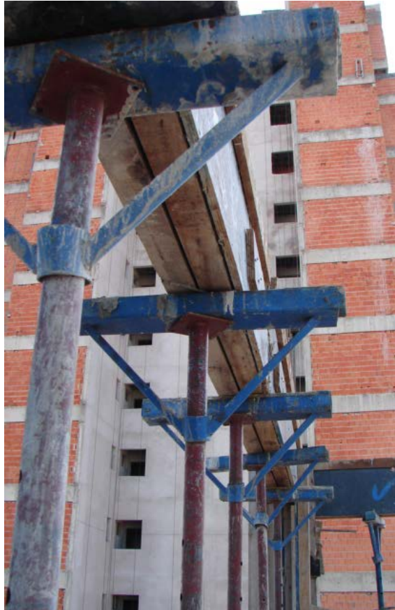
Figura 2-27 - Posicionamento das escoras da viga
