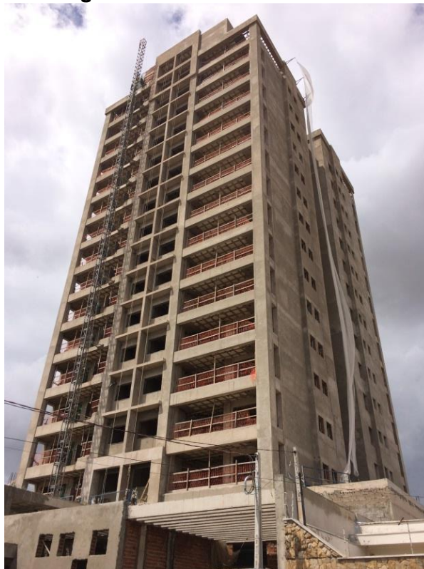
Figura 5-3 - Vista da obra FR-01
