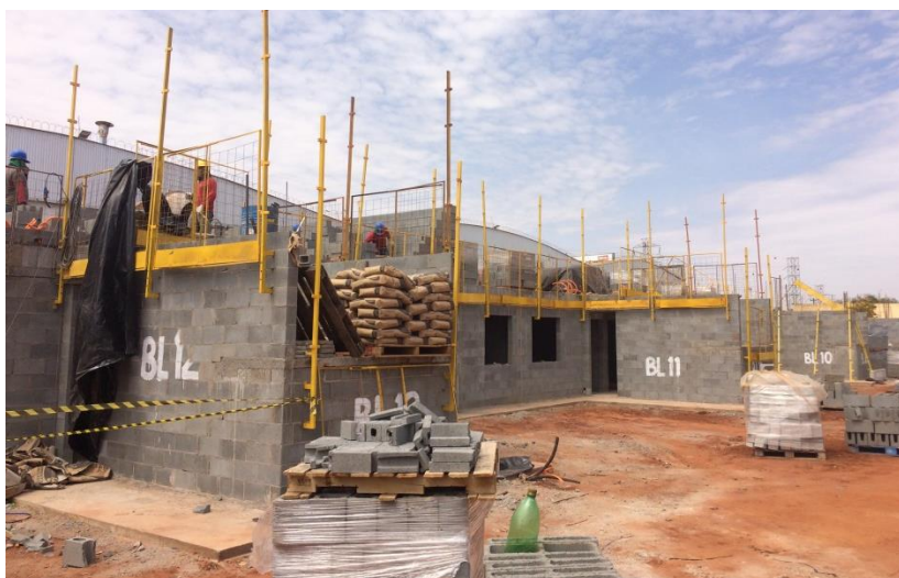
Figura 5-12 – Vista da obra BR-02
