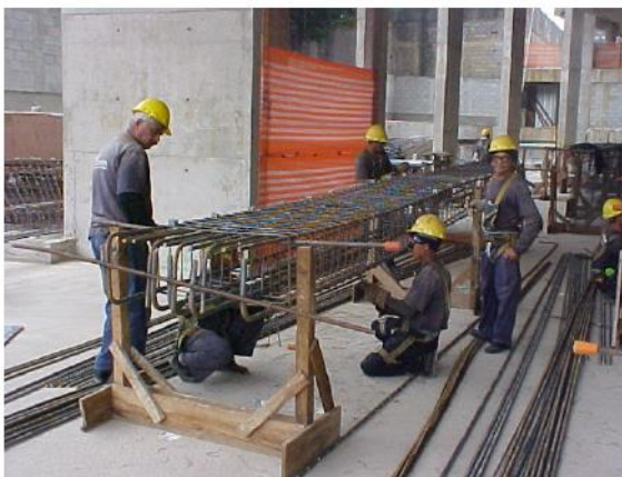
Figura 3-11 – Pré-montagem de armadura para estrutura de concreto
