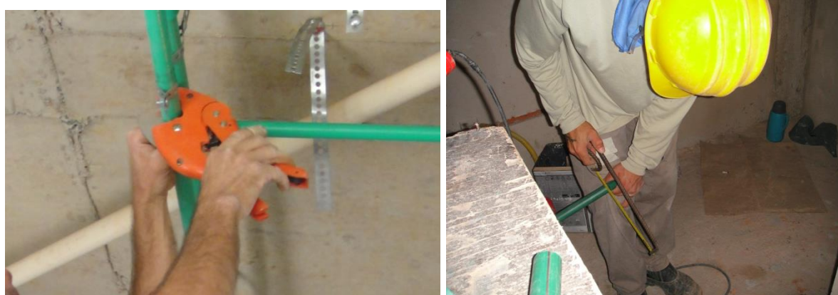
Figura 5-14 – (a) Operação de corte de tubos de PPR com tesoura específica (b) Operação de corte de tubos de PPR com arco de serra
