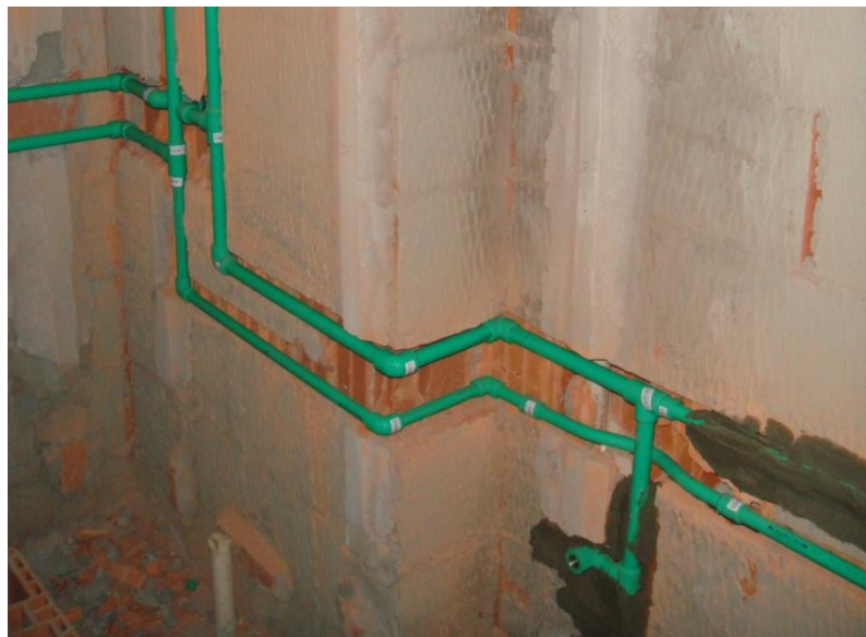
Figura 3-4 - Tubulação de PPB embutida na alvenaria
