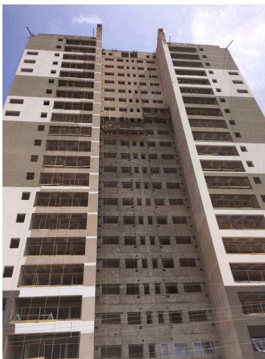
Figura 5-6 - Vista da obra FR-02
