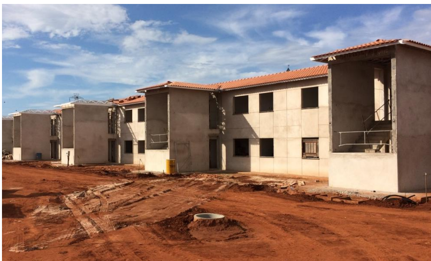
Figura 5-9 – Vista da obra BR-01
