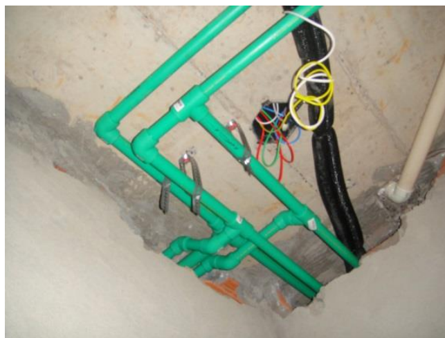
Figura 4-3 - Conexões realizadas na obra
