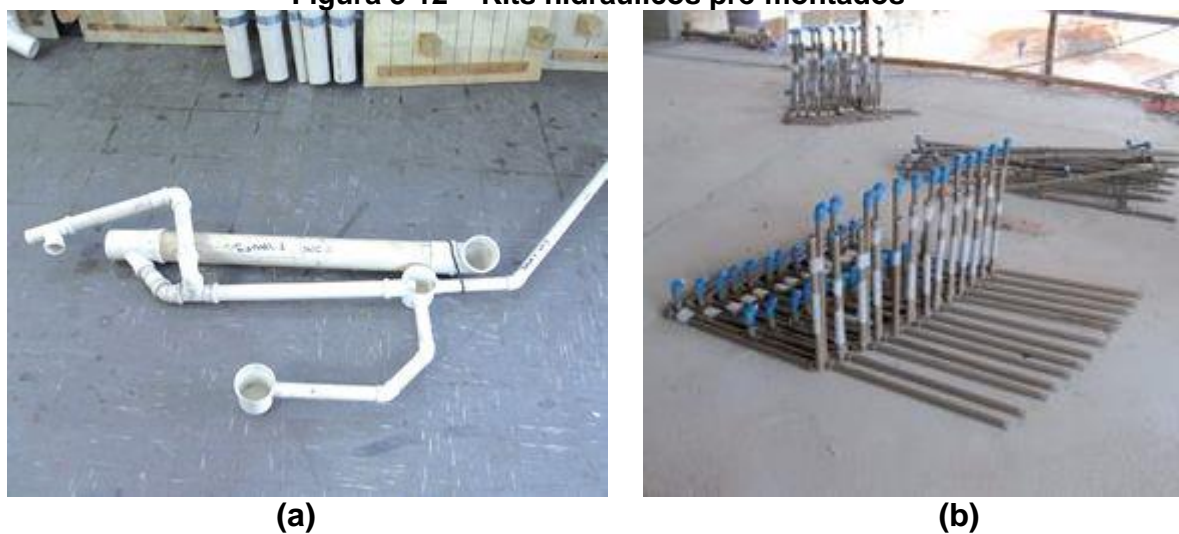
Figura 3-12 – Kits hidráulicos pré-montados
