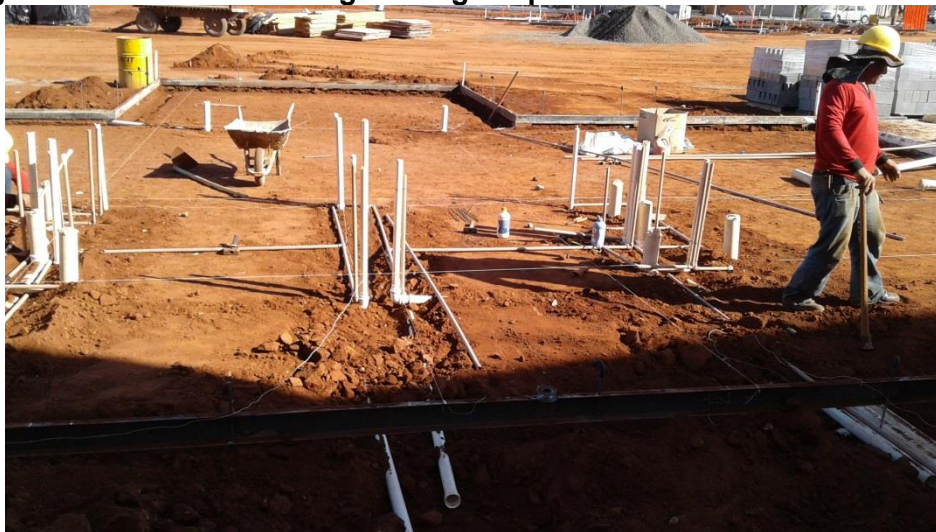
Figura 5-28 – Ramais de esgoto e águas pluviais sobre radier. Obra BR-02
