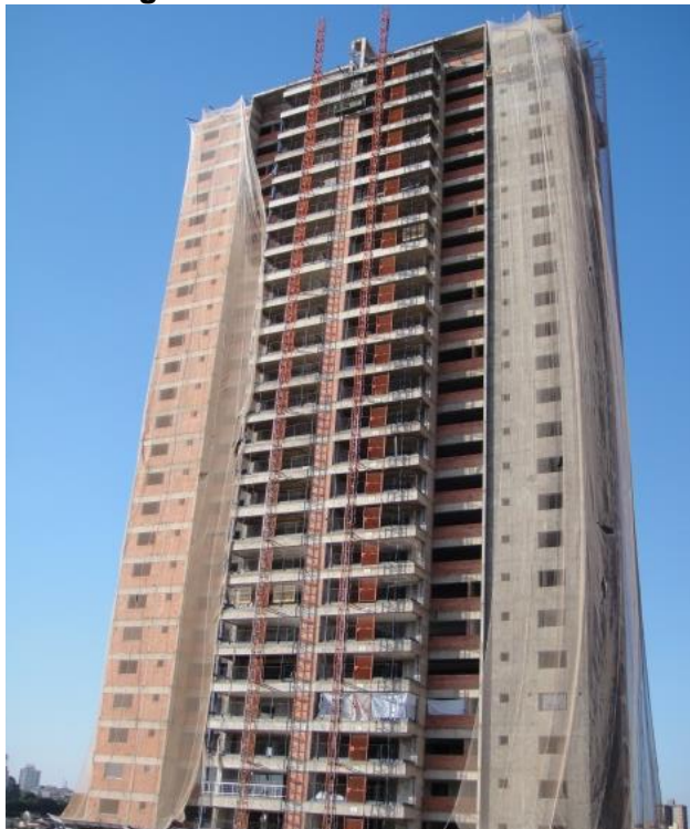
Figura 5-1 - Vista da obra RP-01
