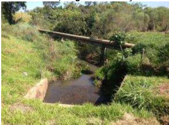
**Figura 78 - Cruzamento do córrego com a Rodovia Washington Luís, águas das nascentes N1 a N6 (2 Ø 1000mm).**
