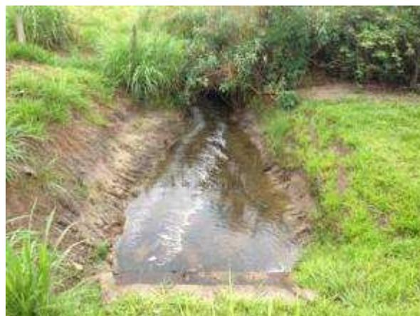
Na vistoria ao sítio Paraíso, verificou-se a existência de um reservatório de contenção de cheias, executado pela Prefeitura Municipal na tentativa de controlar os alagamentos que ocorrem na região do Kartódromo. Este reservatório encontra-se em bom estado de conservação e isolamento, conforme demonstram as Figuras 65 e 66.
