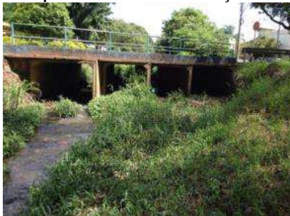
**Figura 105 - Seção do córrego a jusante da travessia da Rua Oscar de Souza Geribelo. Acúmulo de sedimentos ao lado dos gabiões.**
