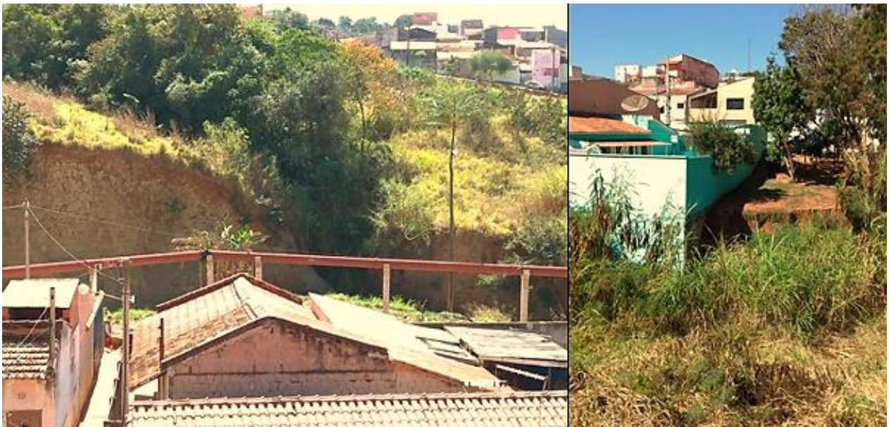
Figura 35. Ocupações irregulares em taludes expostos próximos ao Córrego Matadouro Velho, no município de Tatuí, classificando área de risco.
