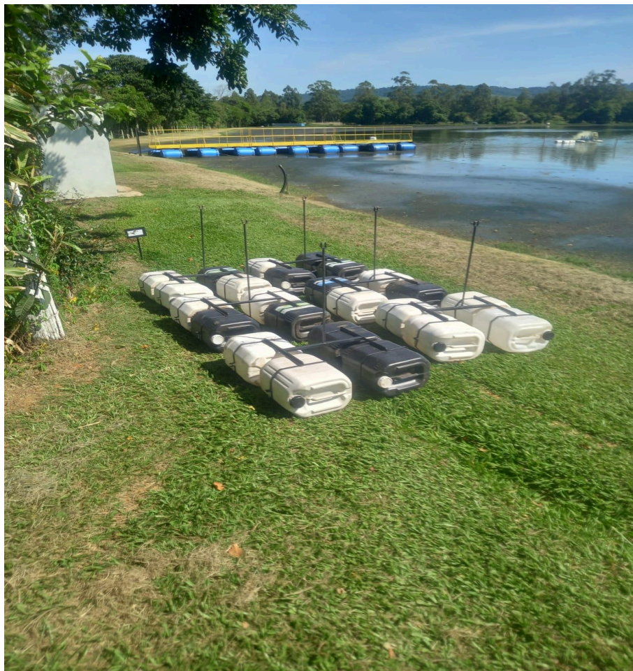
Figura 6 – Suportes flutuantes utilizados para suspender os cabos elétricos acima do nível da água na distribuição elétrica da lagoa
