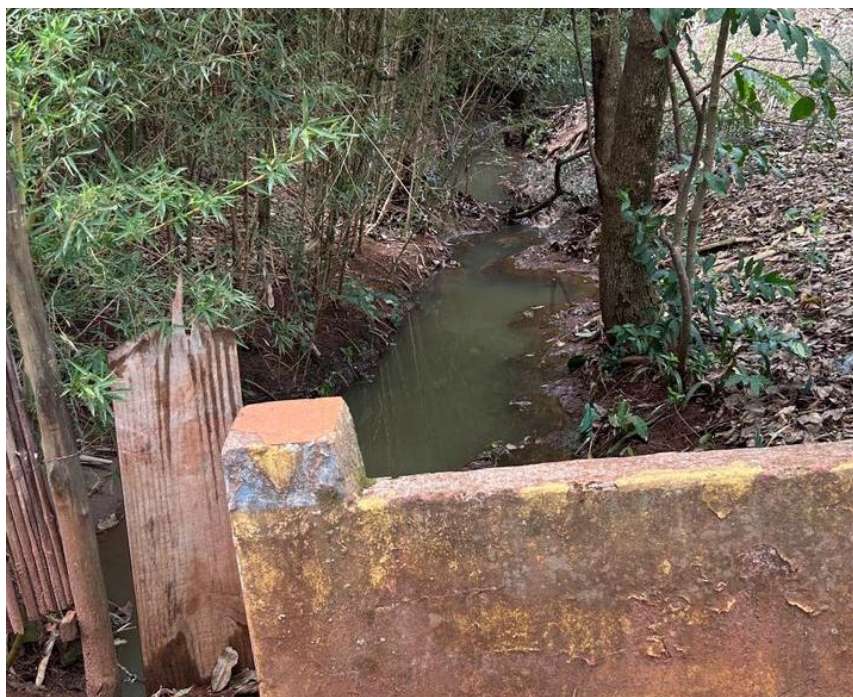
Figura 6 - Vista montante do corpo receptor
