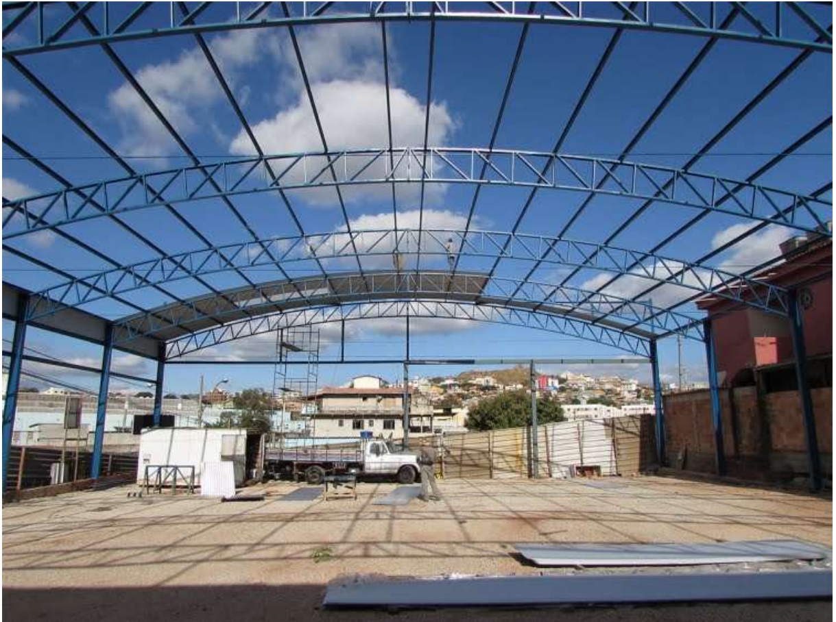
Figura 11 - Exemplo de galpão em arco em construção
