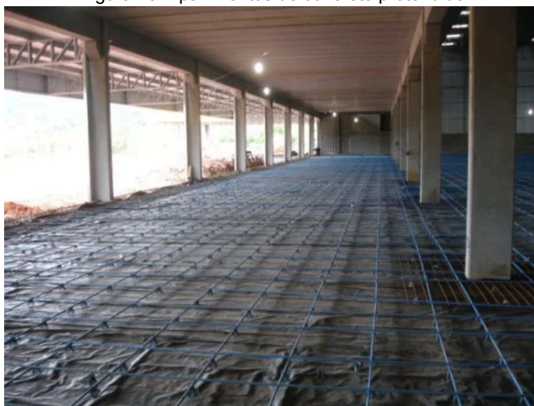
Figura 10 - pavimentos de concreto protendido
