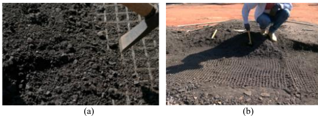
Figura 3.17 – Exumação das geogrelhas: (a) Ferramenta usada; (b) Desagregação do RAP.
