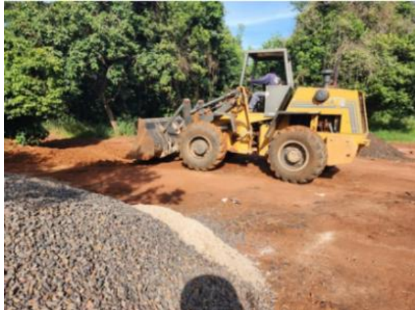
Figura 3.9 – Execução do nivelamento do terreno natural.
