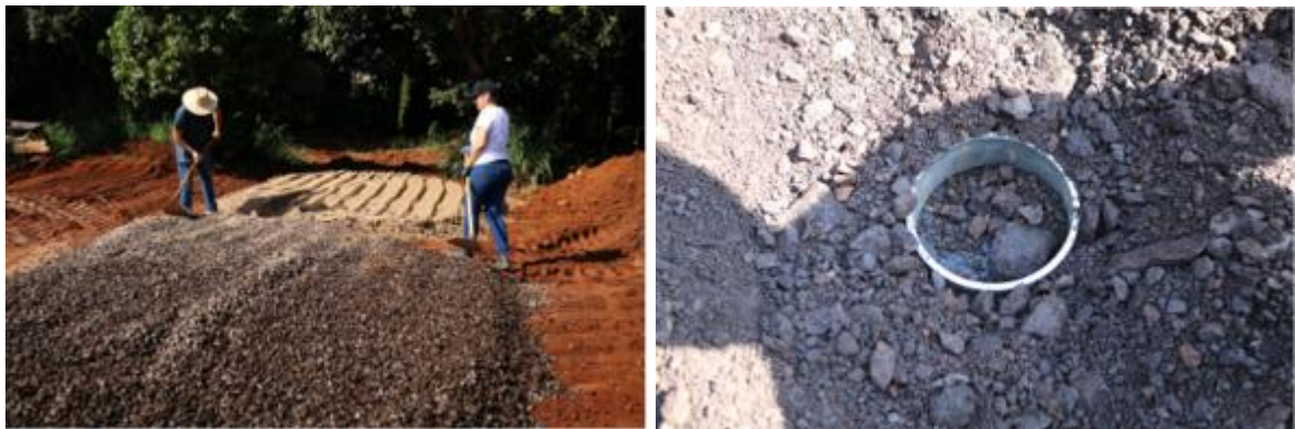
Figura 3.10 – Execução da camada de base e controle de compactação: (a) Aplanamento do material; (b) Cilindro para controle de compactação.
