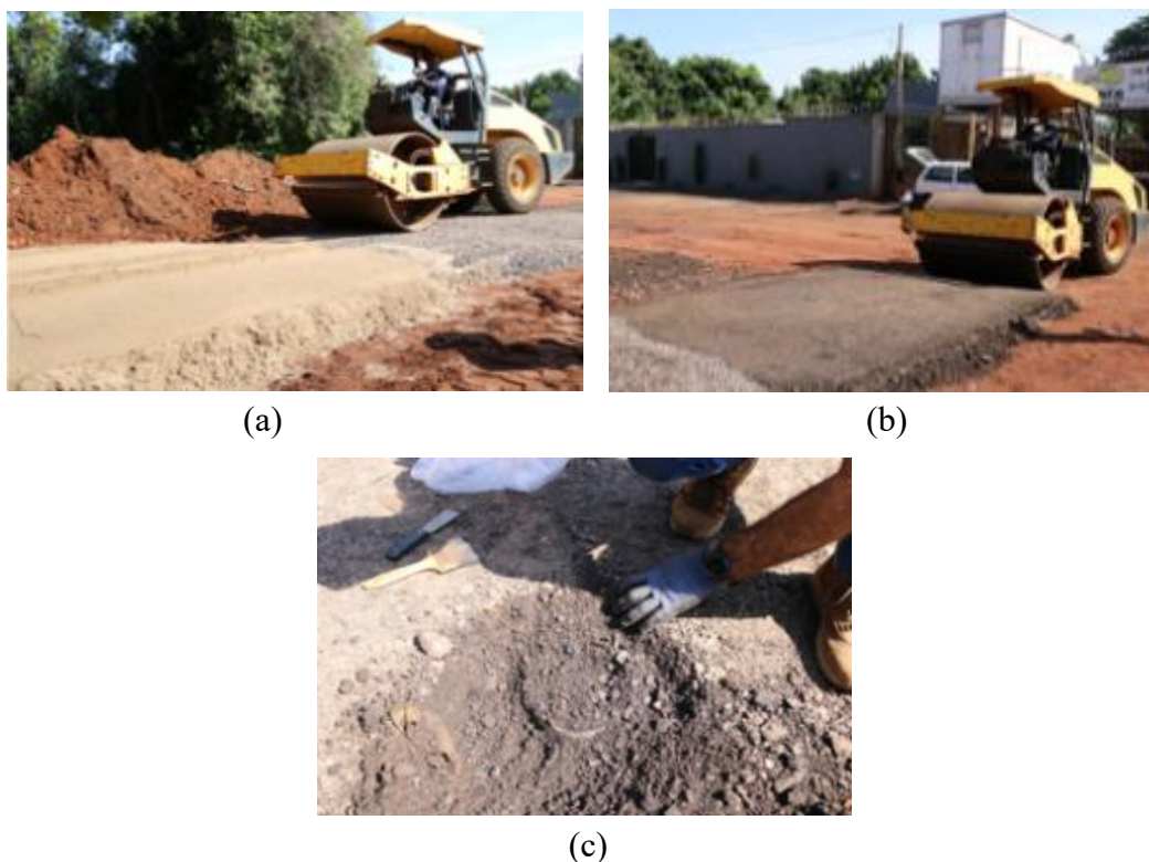
Figura 3.12 – Compactação da camada de base: (a) Camada da areia; (b) Camada do fresado; (c) Extração do cilindro para aferir o G.C.
