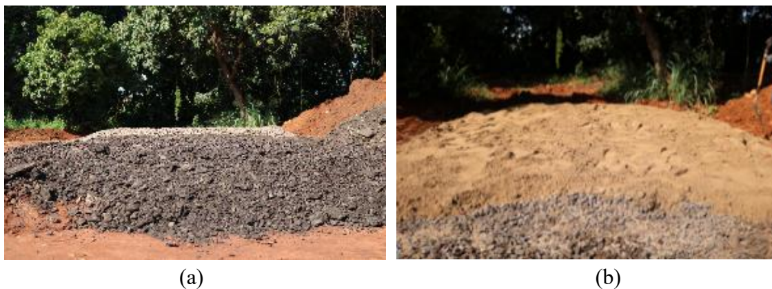
Figura 3.11 – Execução da camada de base: (a) RAP; (b) Areia.
