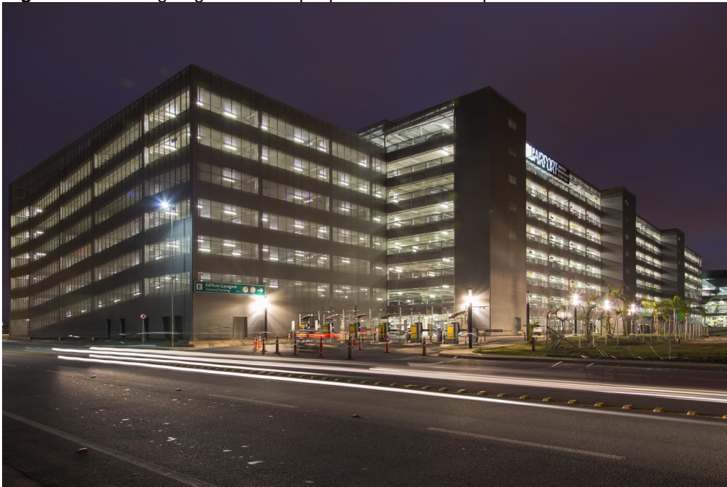
Figura 1 - Edifício garagem de múltiplo pavimentos – Aeroporto de Guarulhos Terminal 3
