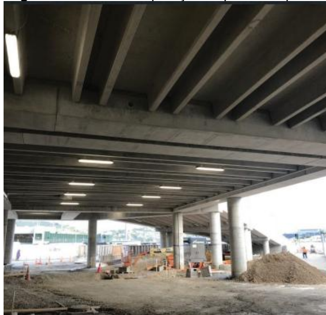
Figura 11 - Obra com aplicação de painéis duplos tê
