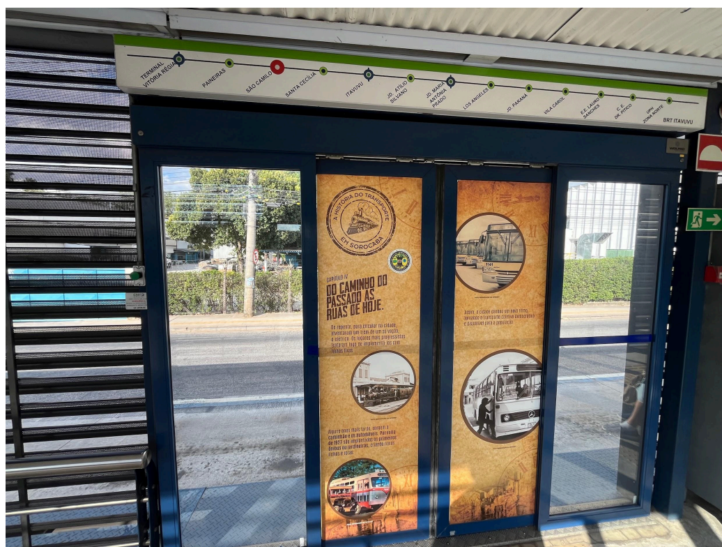
Figura 3: Porta automática de embarque e desembarque, na estação São Camilo.
