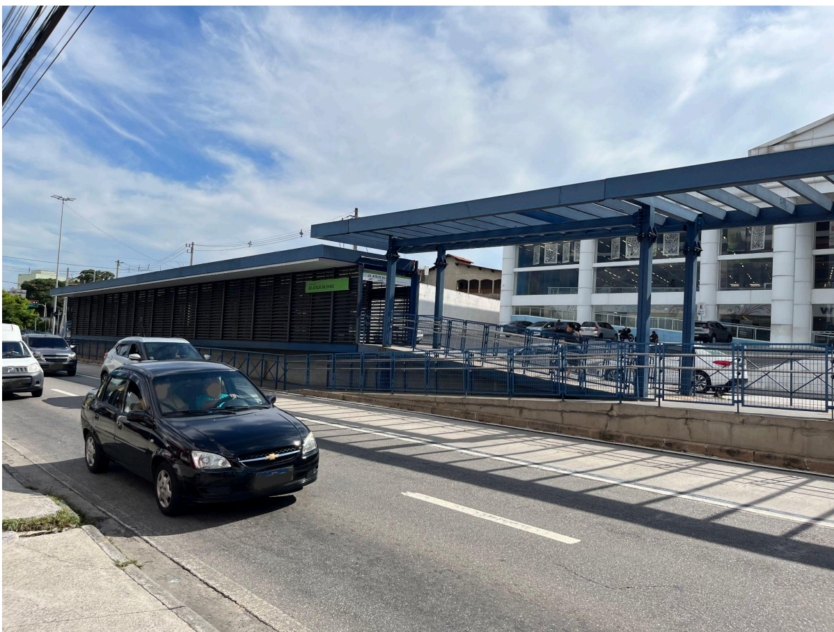
Figura 4: Estrutura da Estação Jardim Atílio Silvano “Ricardo Caldini”, sentido bairro.
