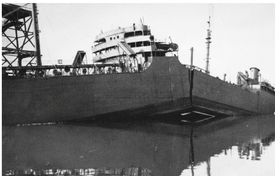
Figura 1.1: Navio Schenectady com casco rompido por fatura frágil em porto Polonês [5].
